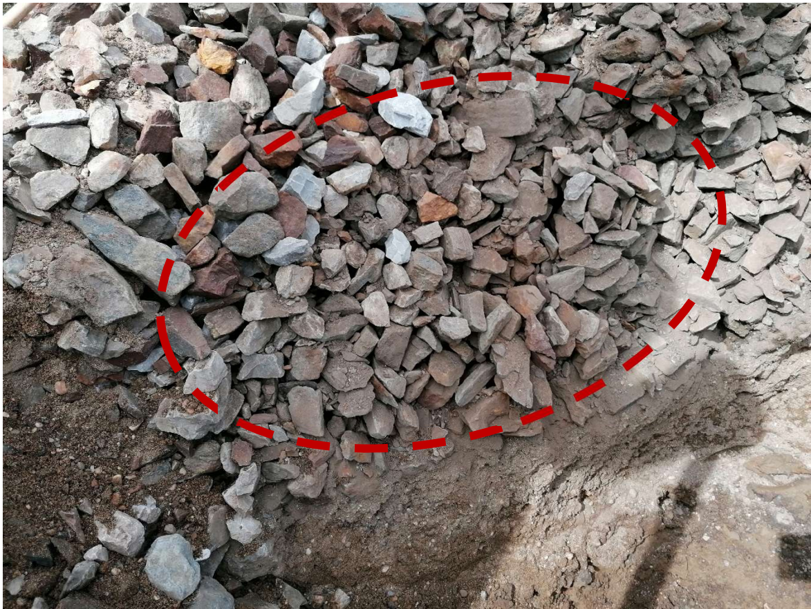
Slika 20. Naslage geotehničke jedinice 3 - Tucanika u sklopu sondažne jame SJ-34 (Geotech d.o.o)
