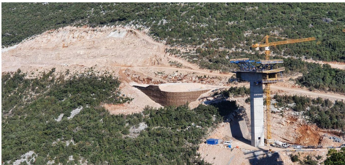
Slika 27. Armirano tlo na poziciji upornjaka mosta [23]
