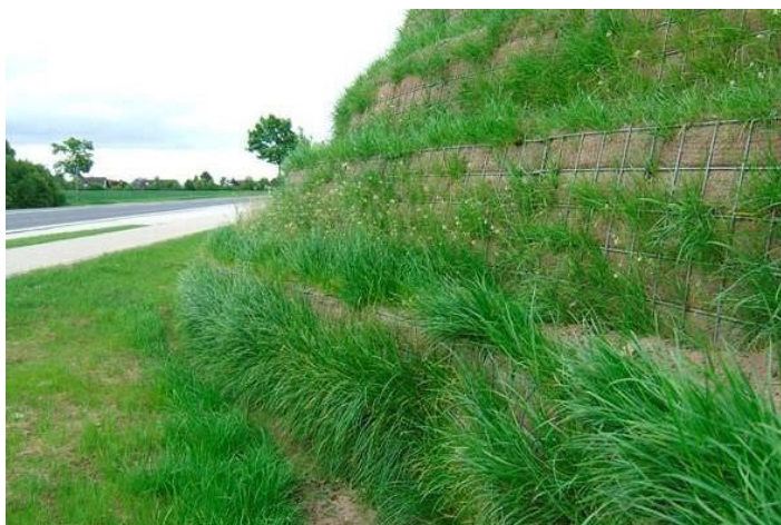
Slika 33. Green Tensar Wall potporna konstrukcija [25]
