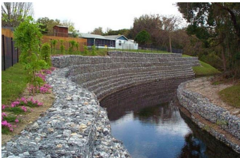
Slika 30. Terramesh sustav [25]
