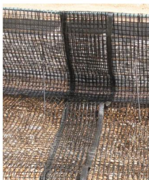
Prijeklop geomreže od 5,0 cm
