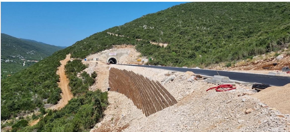
Slika 46. Pogled na izvedenu konstrukciju od armiranog tla sa strane [37]
