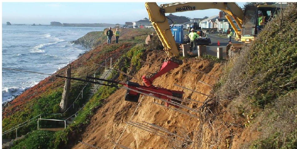
Pobijanje čavala na nepristupačnim mjestima
