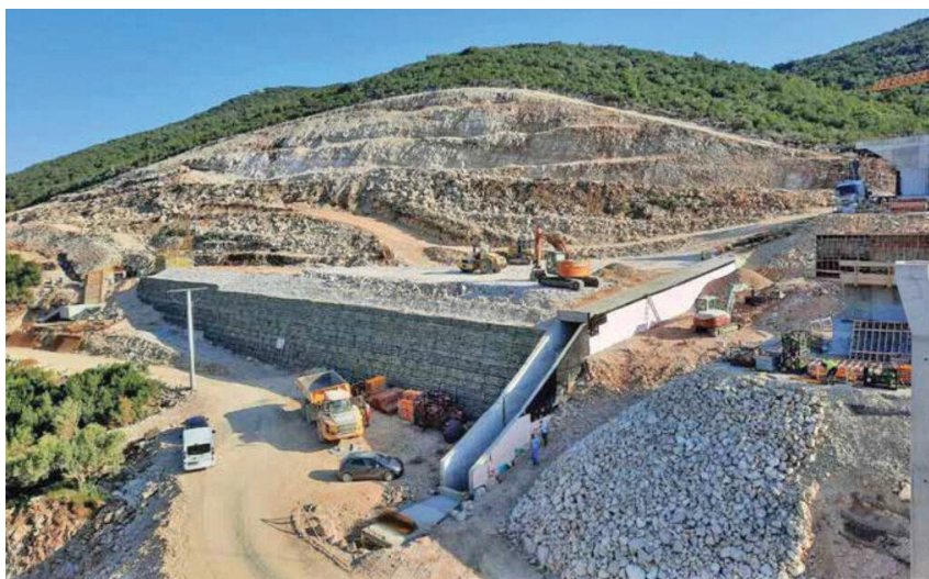
Slika 44. Izgradnja armirane potporne konstrukcije [20]
