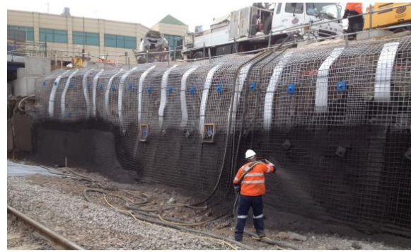
Postavljanje završnog sloja - mlazni beton
