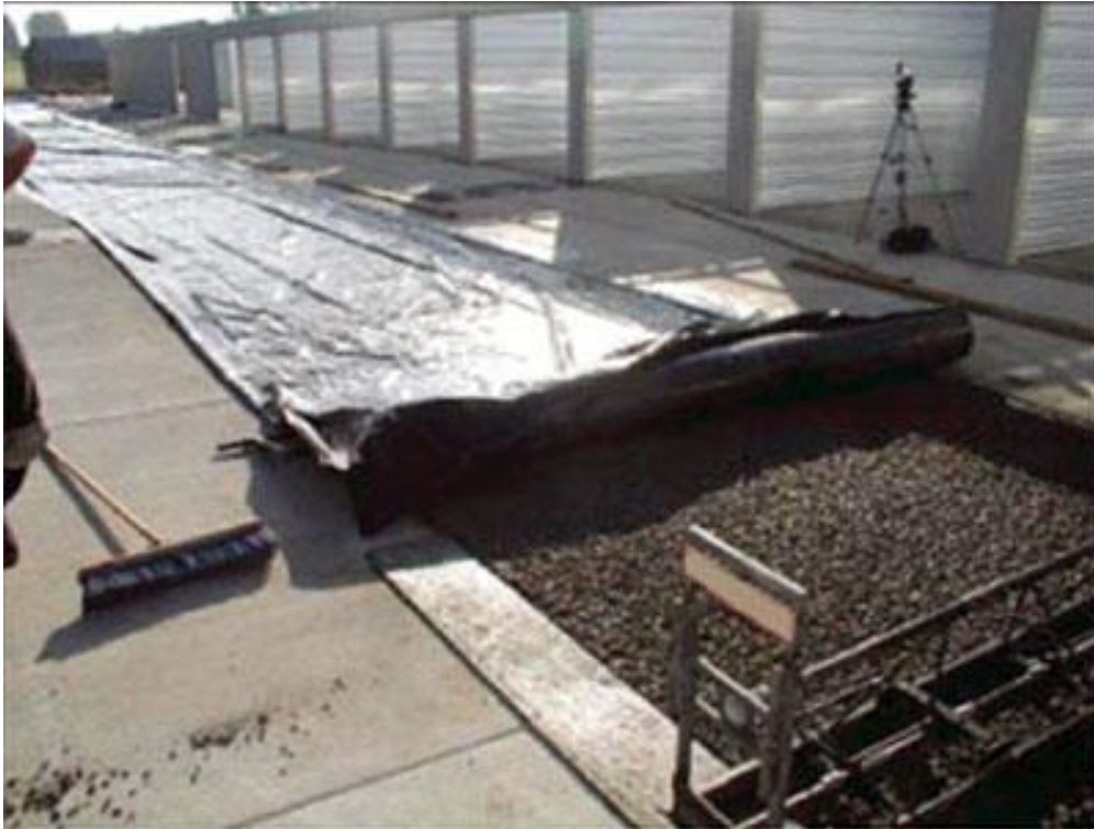
Slika 7: Njegovanje procjdnog betona folijom [6]
