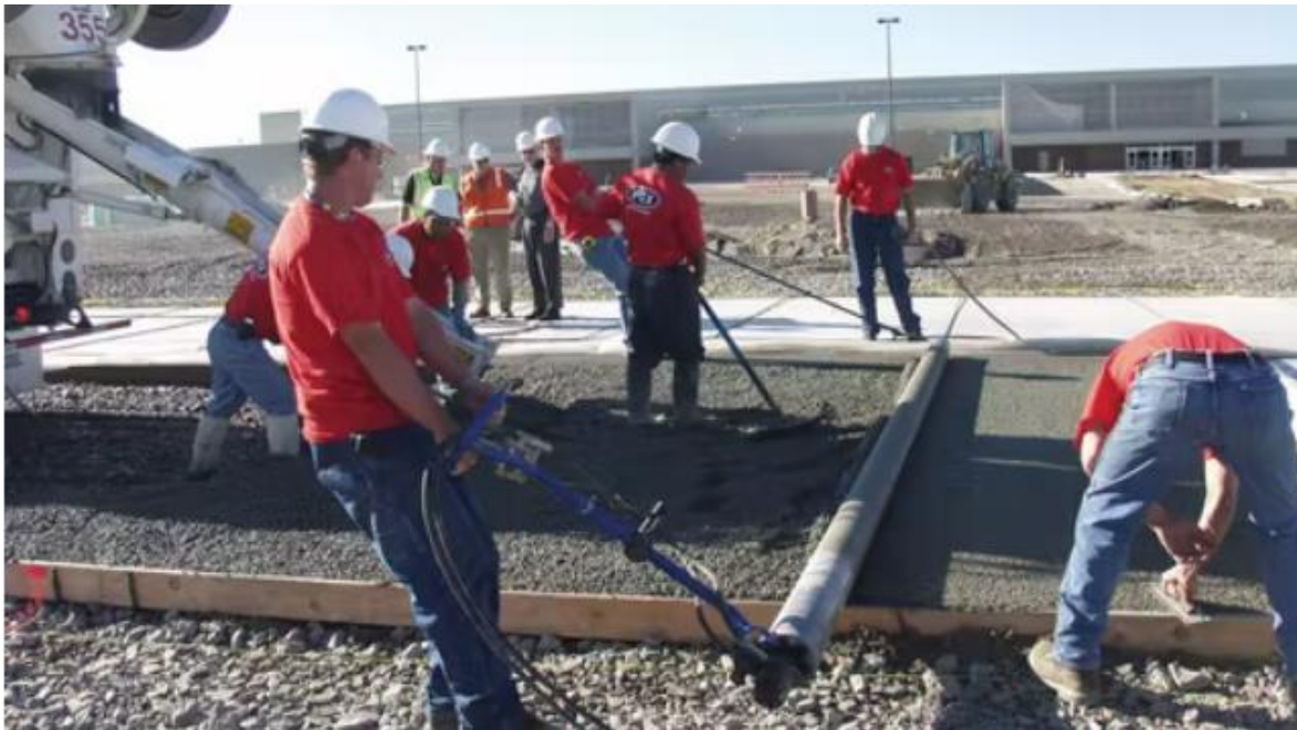
Slika 6: Rasprostiranje procjedinog betona [20]
