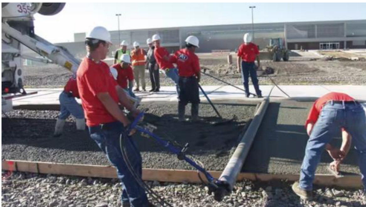
Slika 6: Rasprostiranje procjeddnog betona [20]
