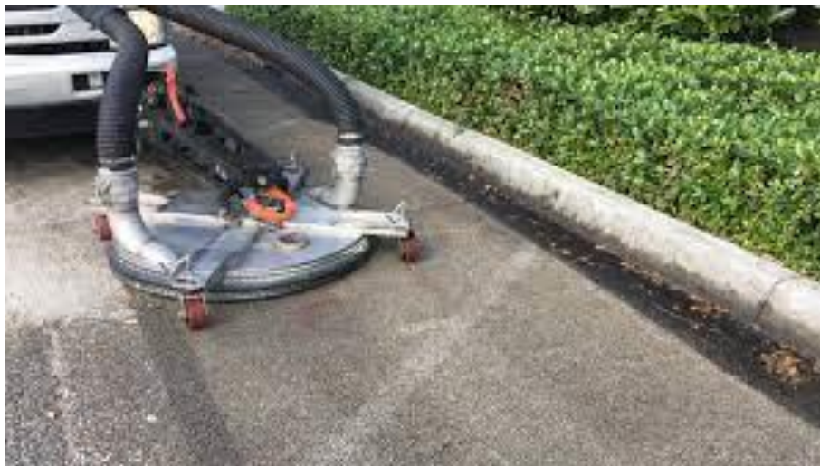
Slika 5: Čišćenje procjednog betona [19]
