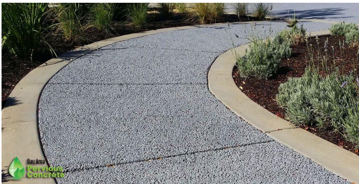
Slika 3: Pješačka staza od procjdnog betona [18]
