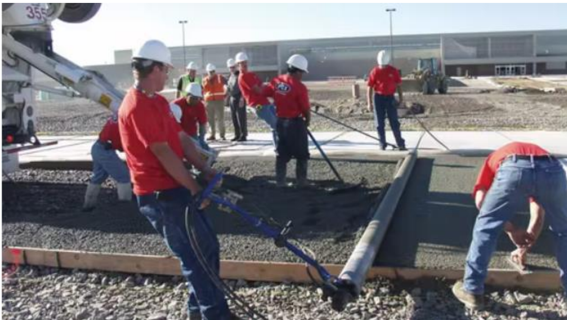
Slika 6: Rasprostiranje procjeddnog betona [20]
