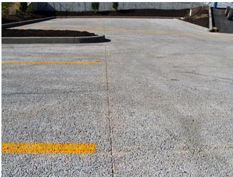
Slika 2: Parkiralište od procjednog betona [6]
