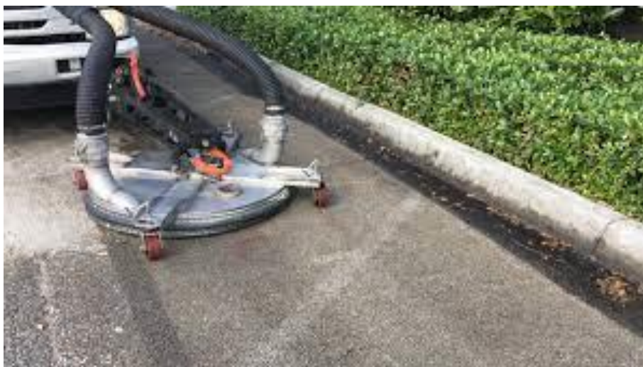
Slika 5: Čišćenje procjednog betona [19]
