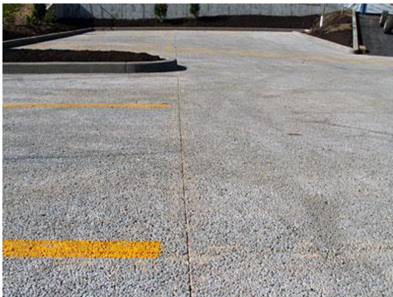
Slika 2: Parkiralište od procjednog betona [6]
