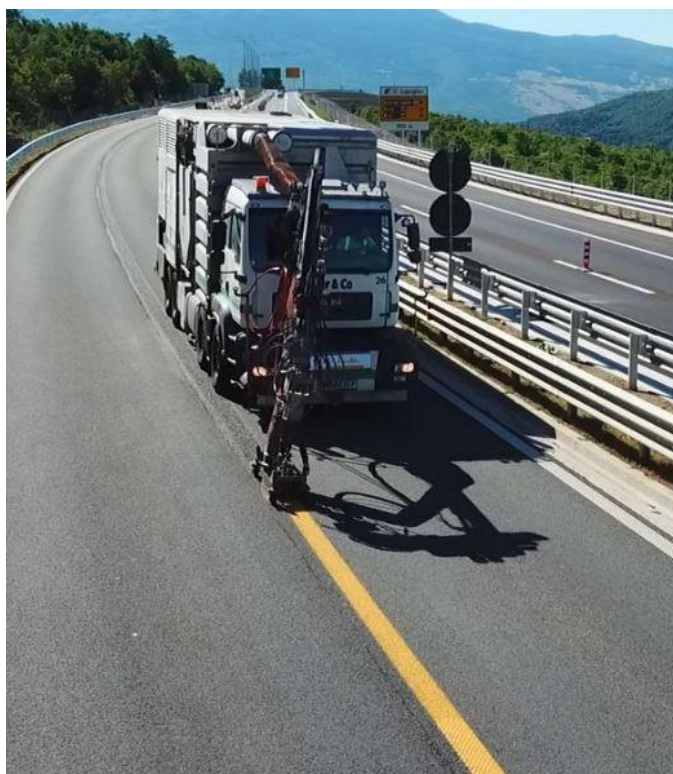
Slika 8. Postupak uklanjanja starih oznaka [19]
