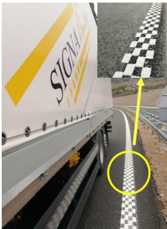
Slika 10. Profilirana horizontalna oznaka [19]
