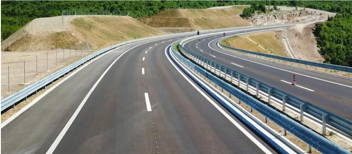
Slika 23. Primjer zaštitne odbojne ograde na autocesti [19]
