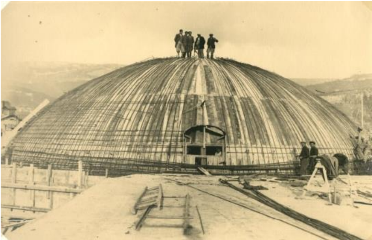
Slika 49: Postavljanje armature kupole [6]
