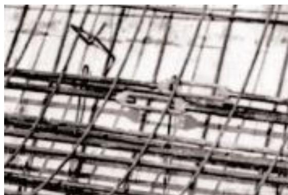
Slika 58: Mehanička spojница armature u prstenu [6]
