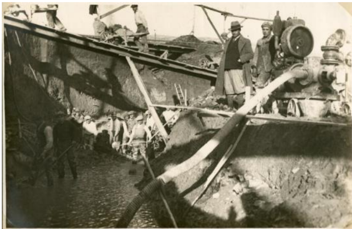
Slika 39: Iskopi za temelje kupole [6]
