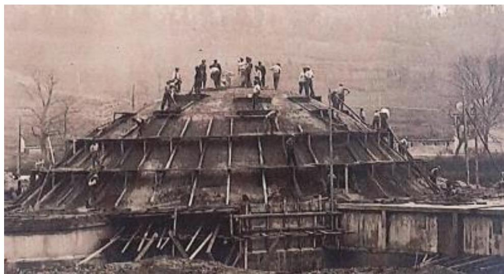
Slika 50: Betoniranje kupole [6]
