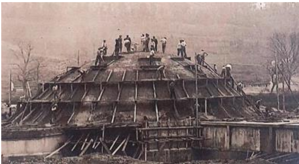
Slika 50: Betoniranje kupole [6]
