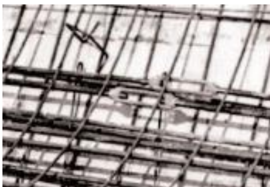
Slika 57: Mehanička spojnica armature u prstenu [4]
