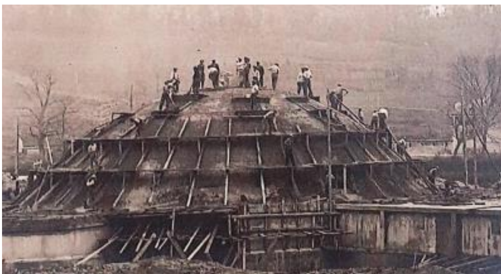
Slika 50: Betoniranje kupole [6]
