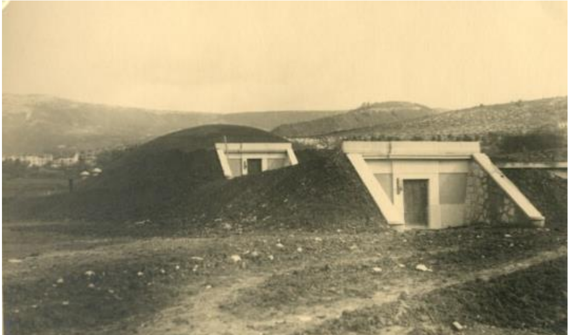
Slika 51: Završena kupola s konačnim slojem zemlje [6]
