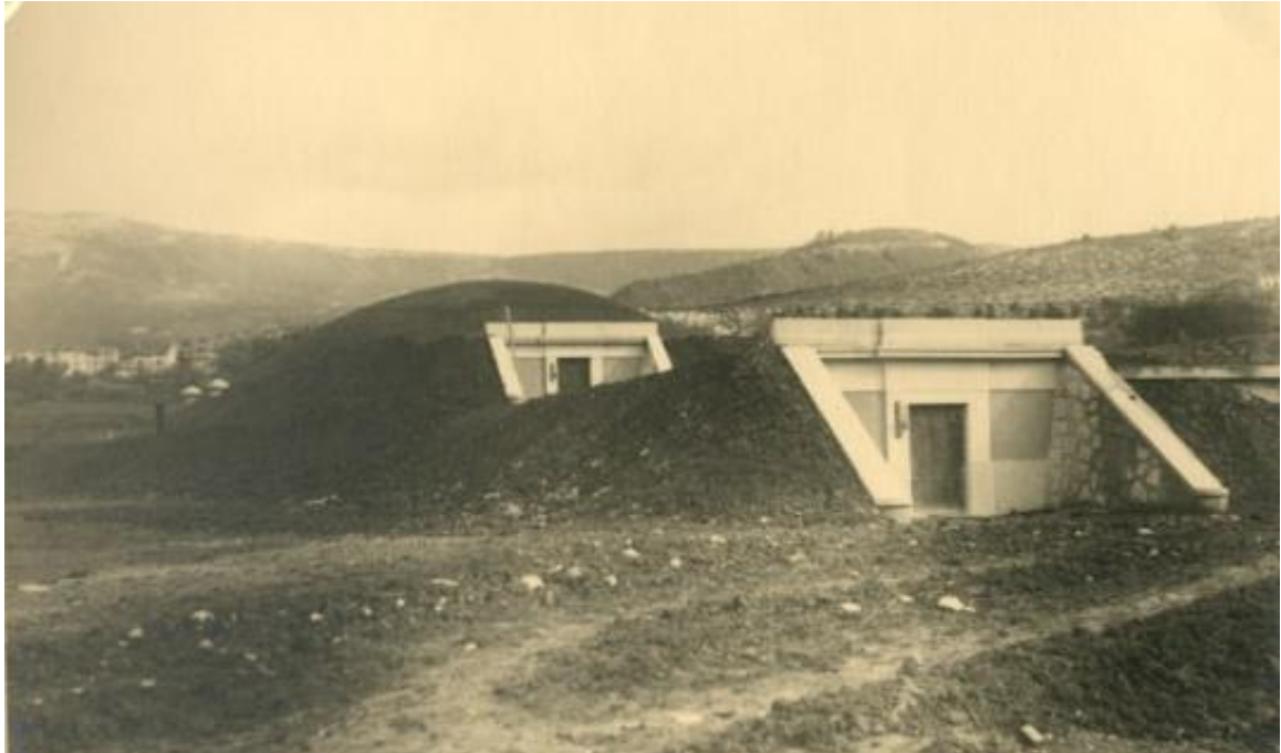
Slika 51: Završena kupola s konačnim slojem zemlje [6]
