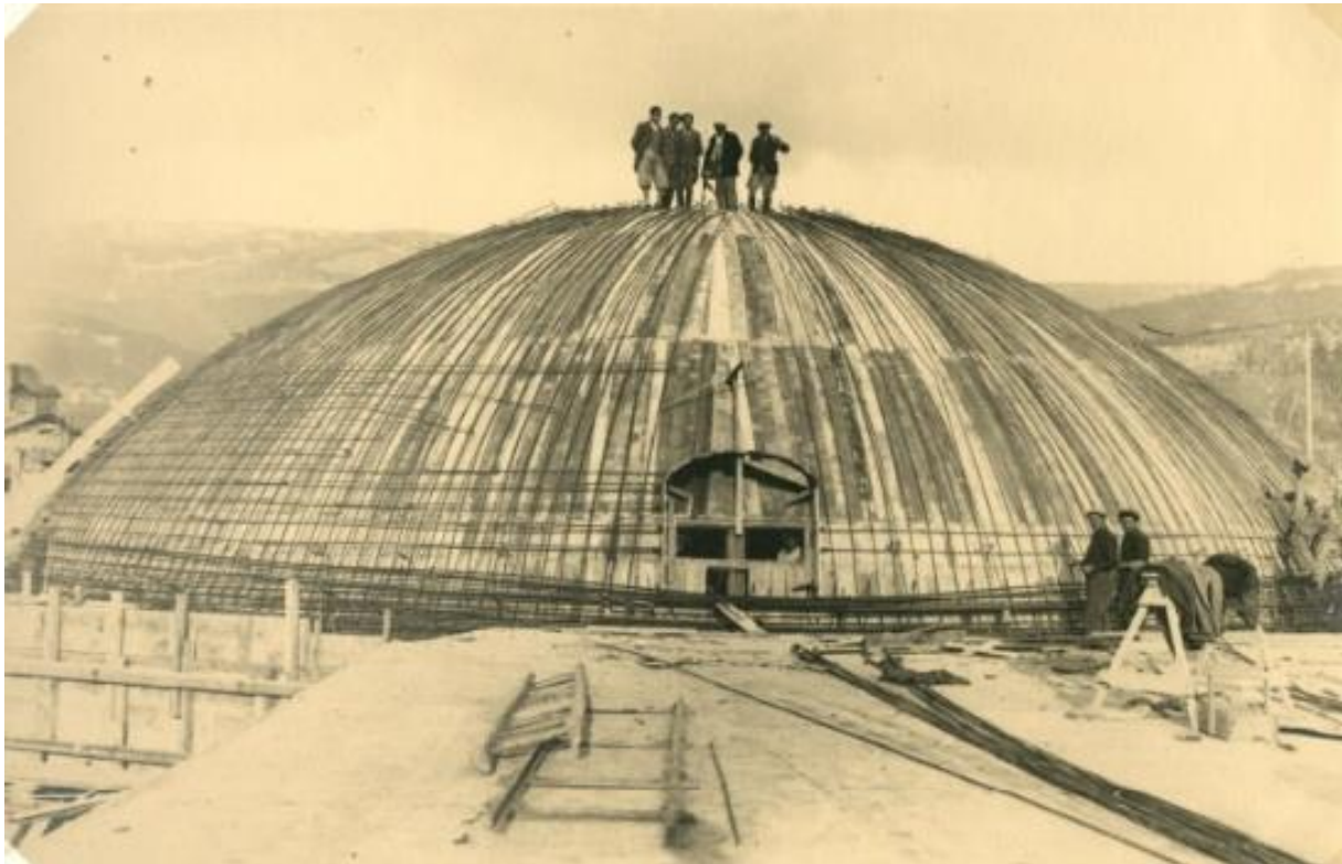
Slika 49: Postavljanje armature kupole [6]
