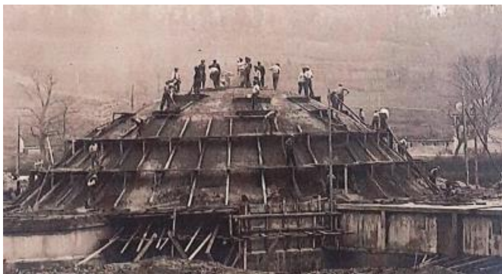
Slika 50: Betoniranje kupole [6]
