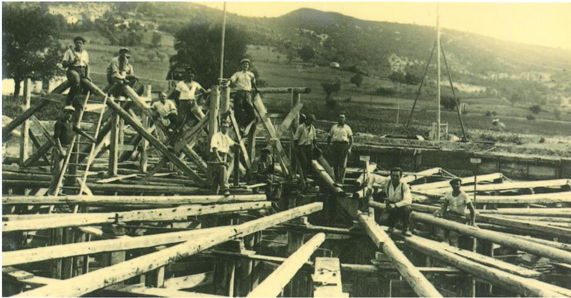
Slika 45: Postavljanje oplata za kupolu [5]
