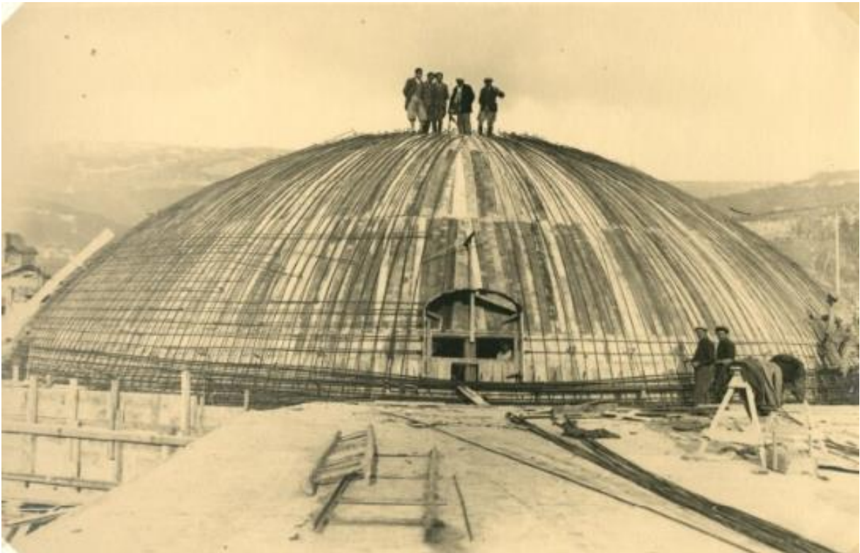
Slika 49: Postavljanje armature kupole [6]
