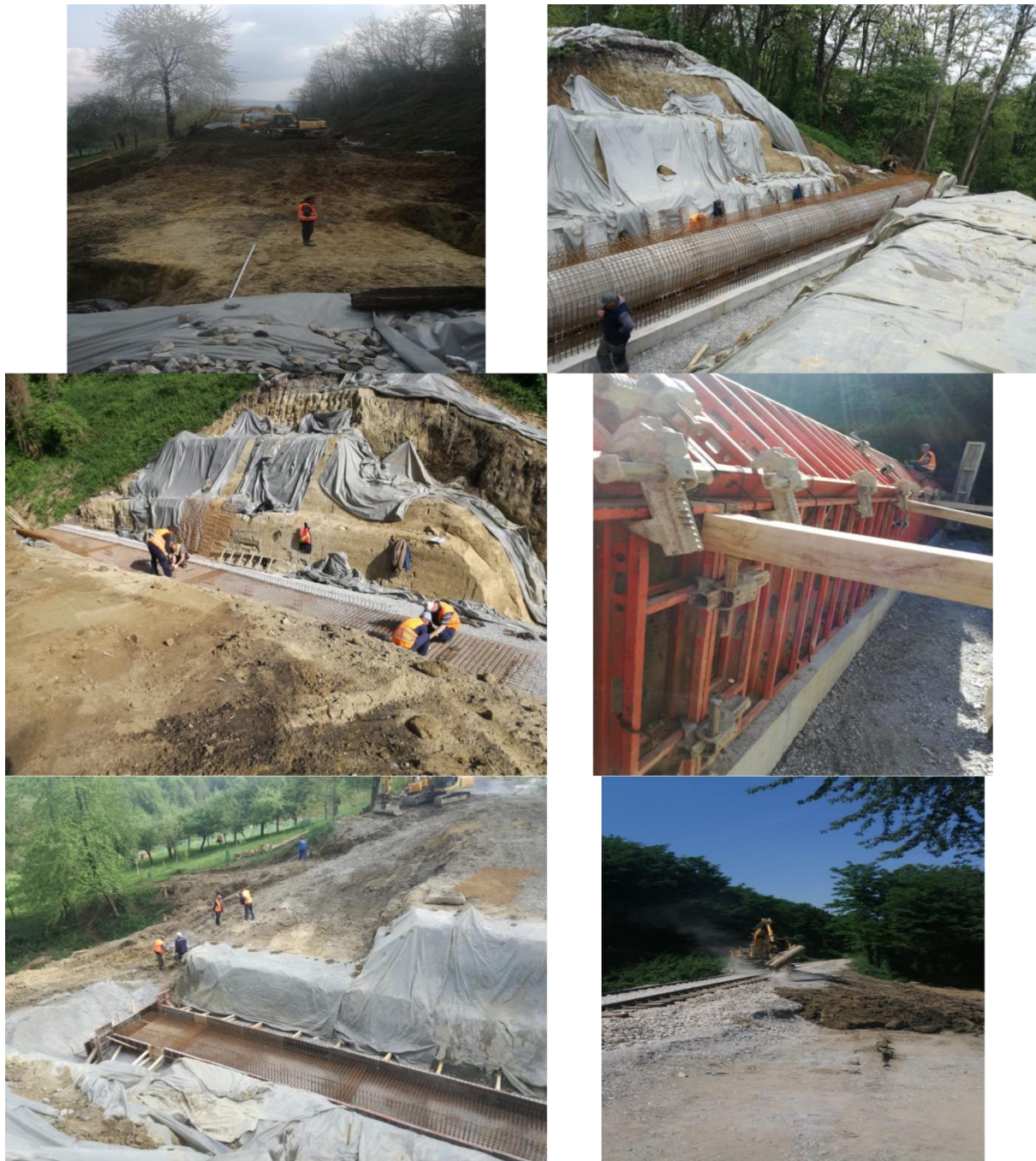
Slika 44. Saniranje klizišta, Đulovac, Pružne građevine
