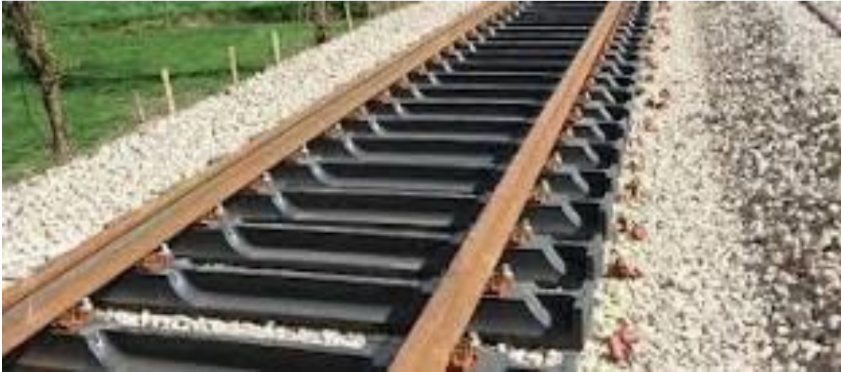
Slika 5. Čelični željeznički pragovi [15]
