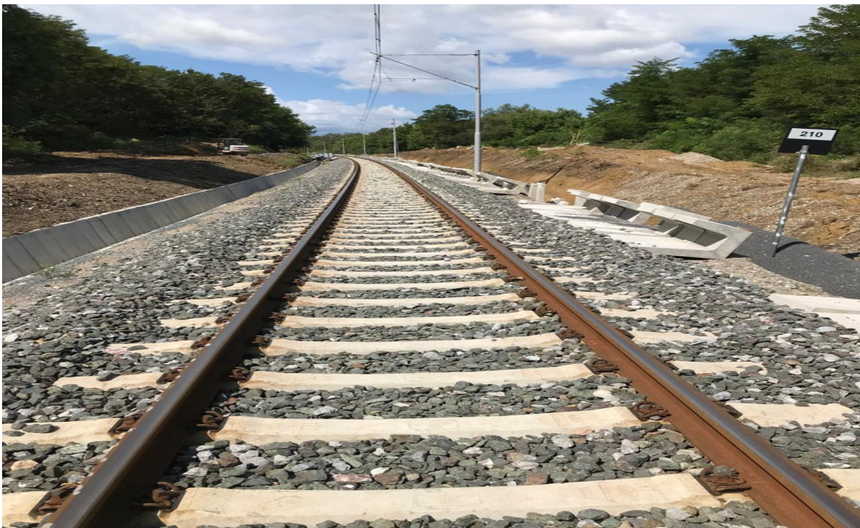
Slika 20. Ugradnja gotovih betonskih odvodnih kanalicama tipa 1, Pružne građevine
