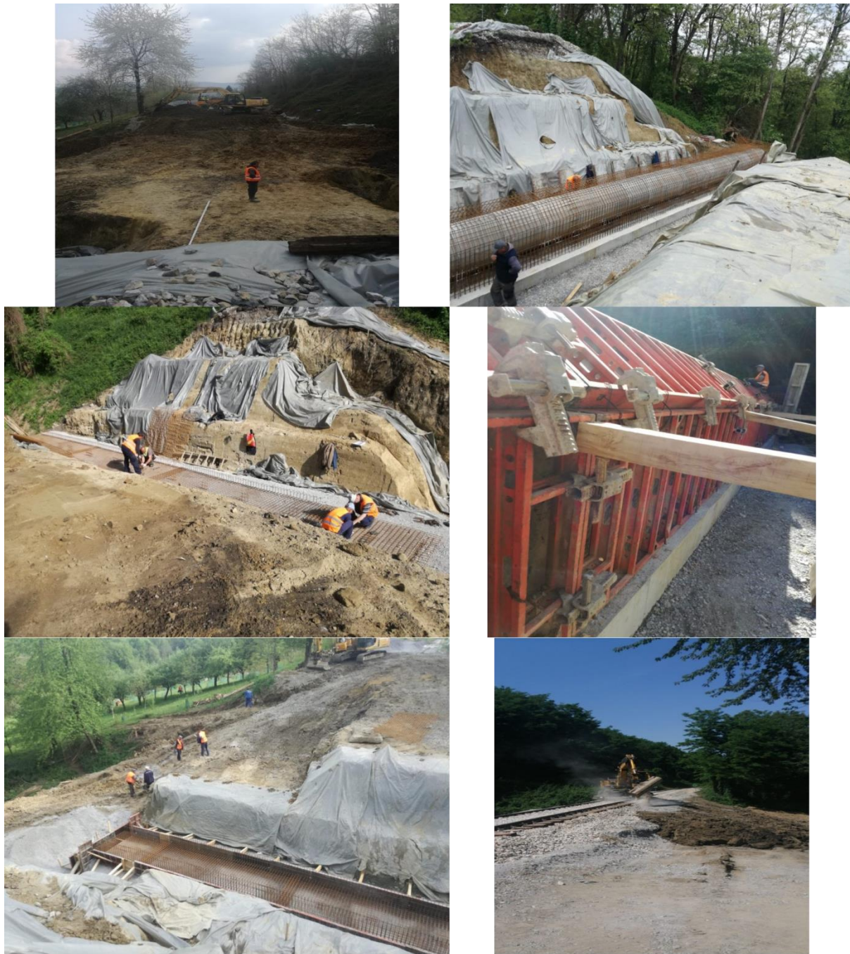
Slika 44. Saniranje klizišta, Đulovac, Pružne građevine
