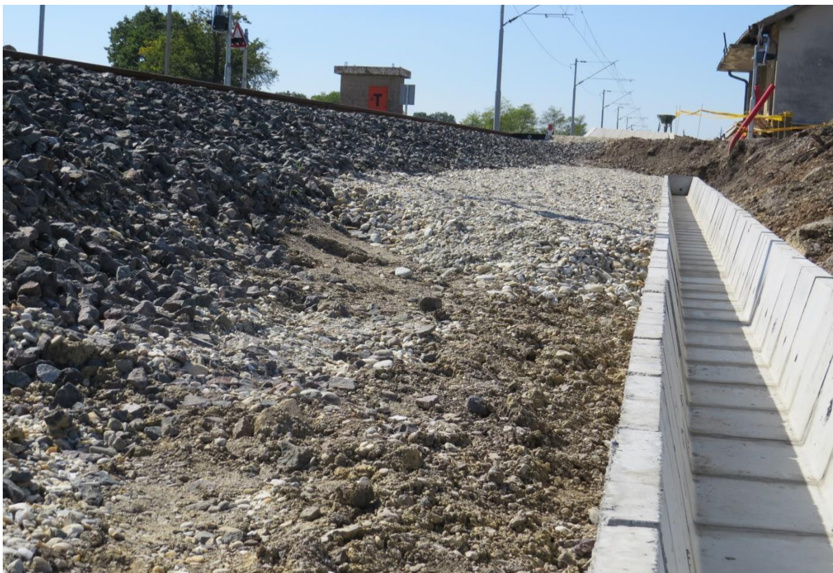
Slika 24. Ugradnja gotovih betonskih kanalice tipa 2, Pružne građevine
