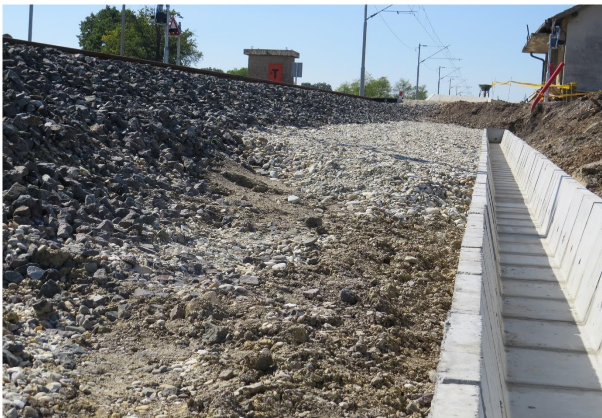
Slika 24. Ugradnja gotovih betonskih kanalice tipa 2, Pružne građevine
