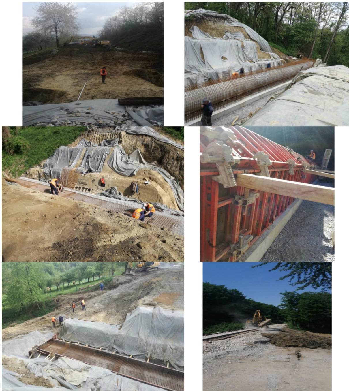
Slika 44. Saniranje klizišta, Đulovac, Pružne građevine
