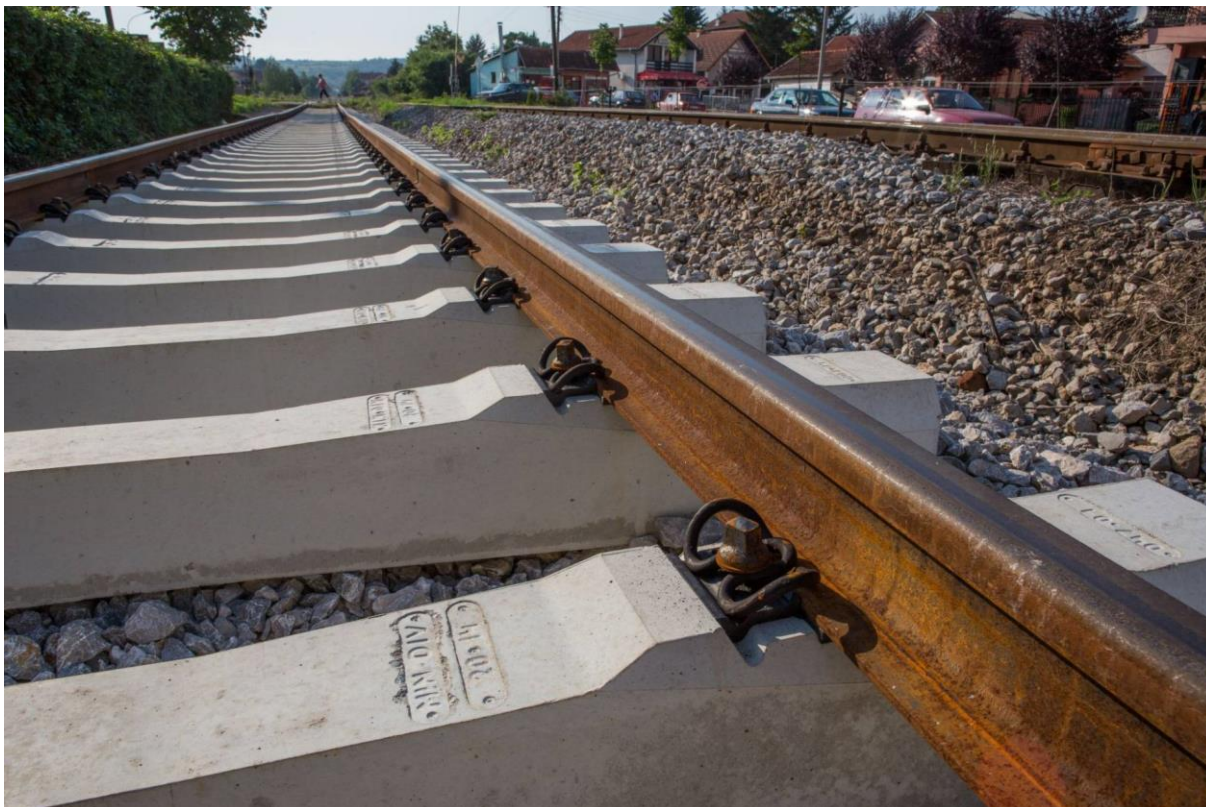
Slika 6. Armirano betonski željeznički pragovi [14]
