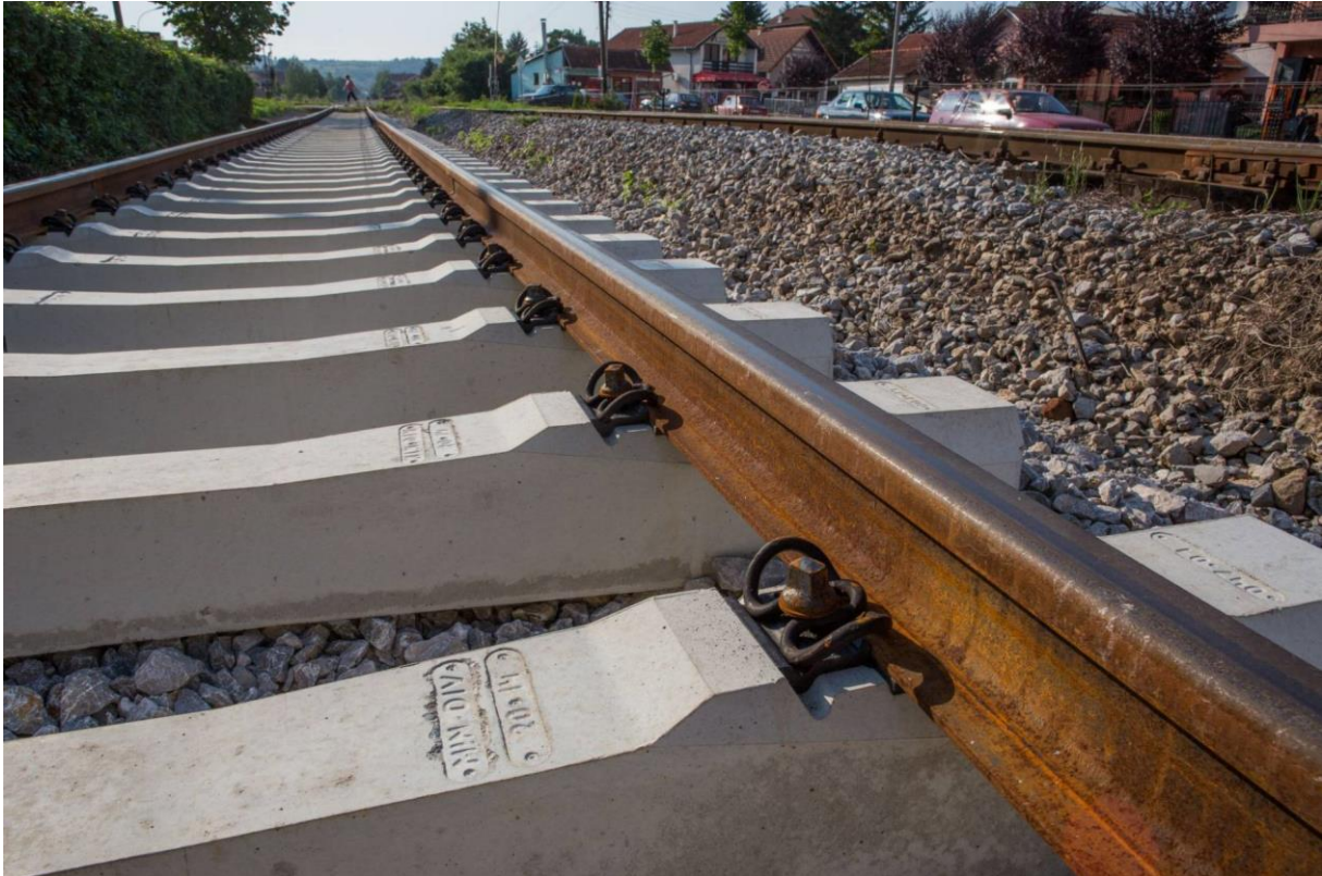
Slika 6. Armirano betonski željeznički pragovi [14]
