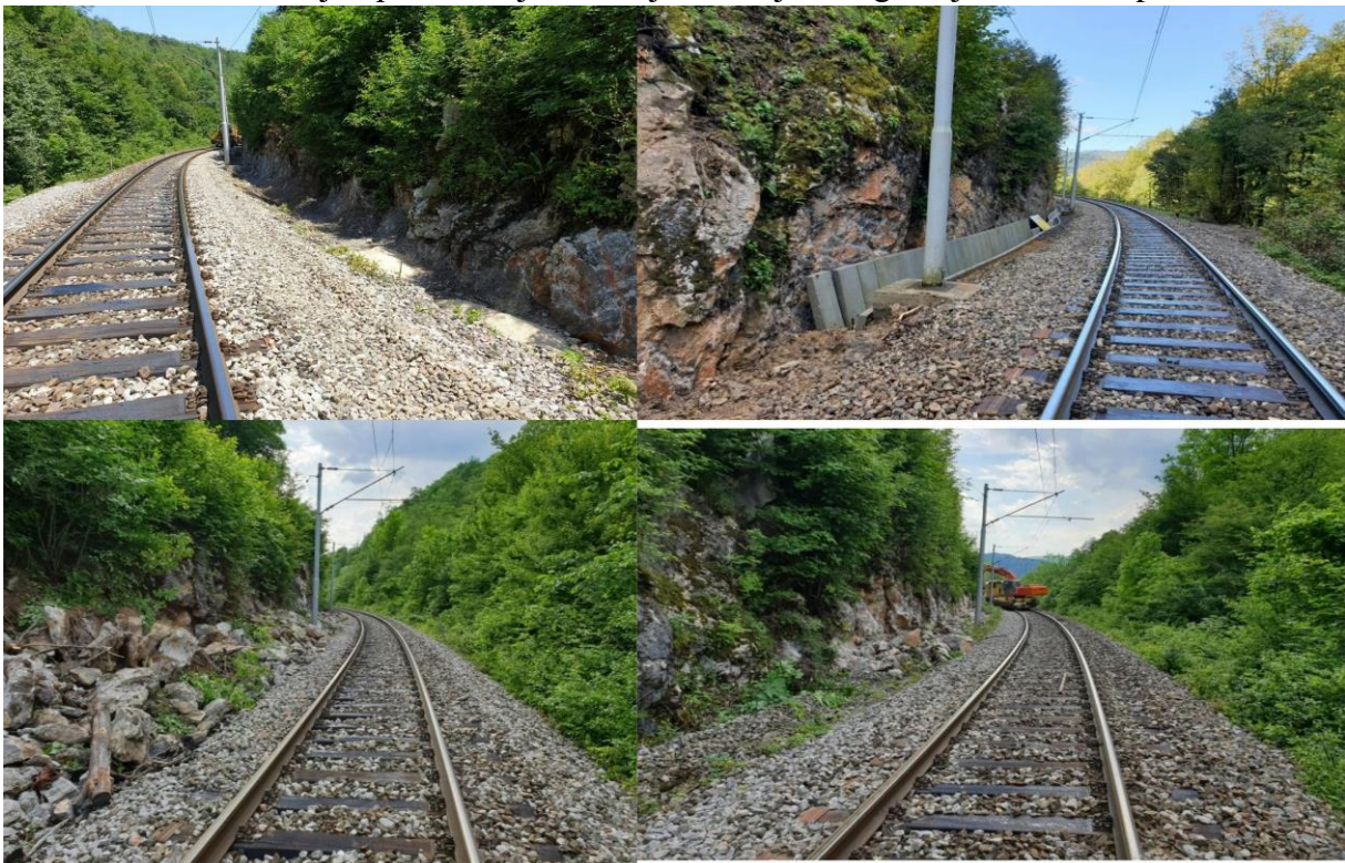
Slika 26. Strojno pikamiranje i ugradnja kanalica, Gomirje, Pružne građevine
