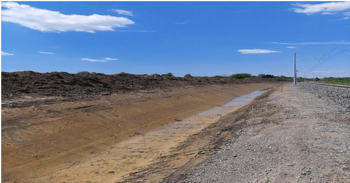
Slika 17. Zemljani zaštitni jarak, dionica pruge Sisak-Sunja, Pružne građevine
