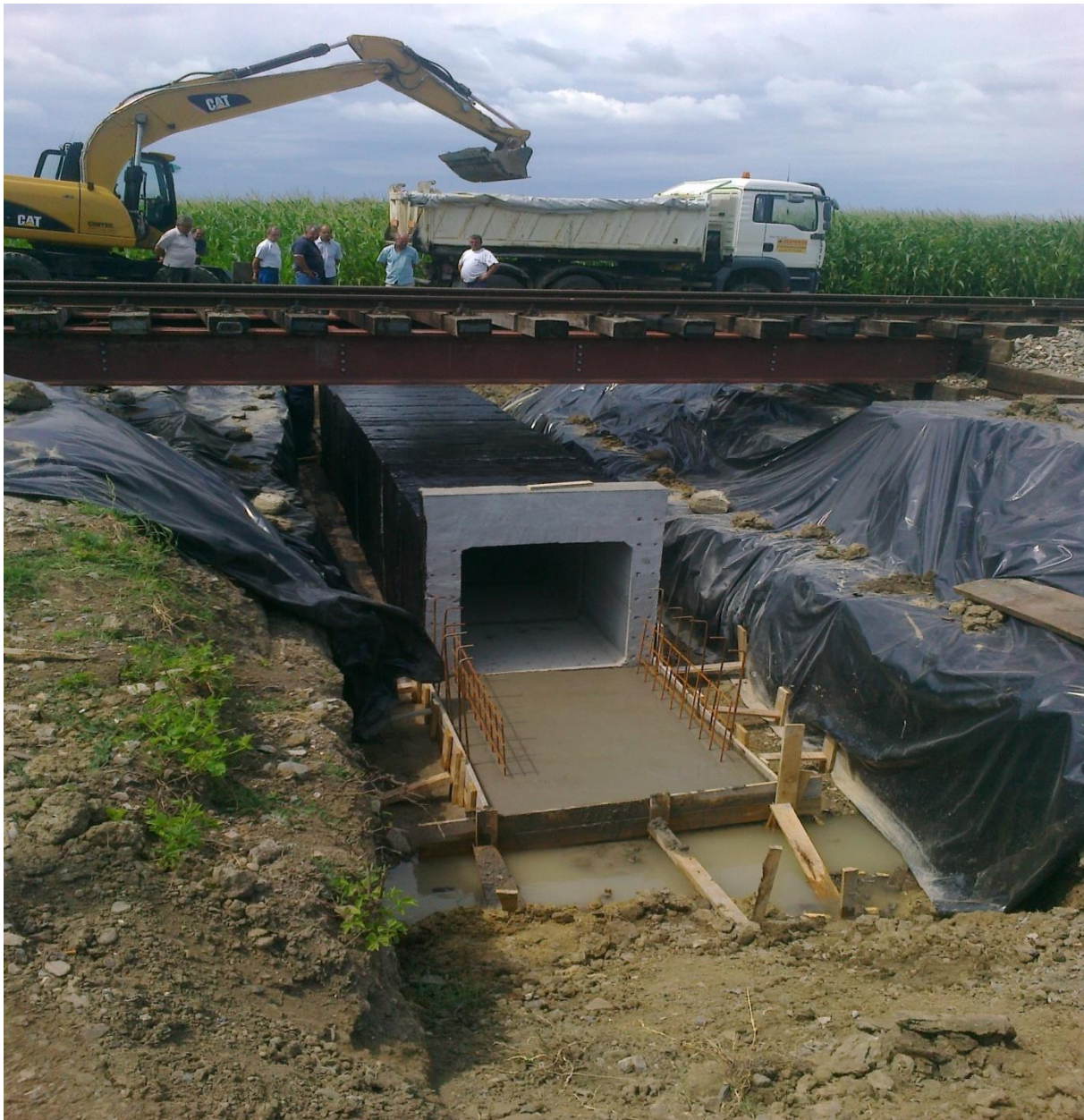
Slika 54. Propust, dionica pruge Vinkovci-Županja, Pružne građevine
