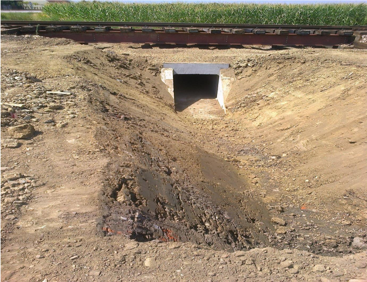
Slika 55. Čeona glava propusta, dionica pruge Vinkovci-Županja, Pružne građevine
