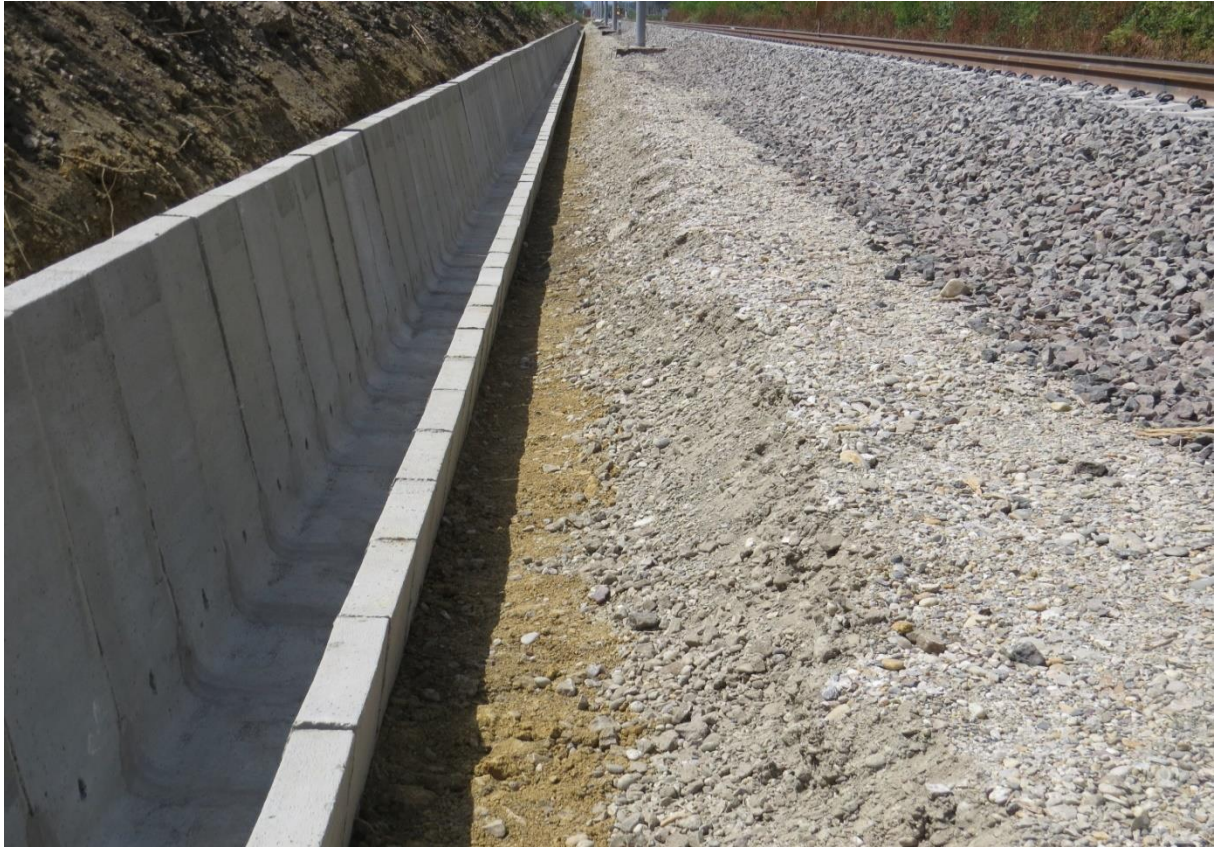
Slika 23. Ugradnja gotovih betonskih kanalice tipa 1, Pružne građevine
