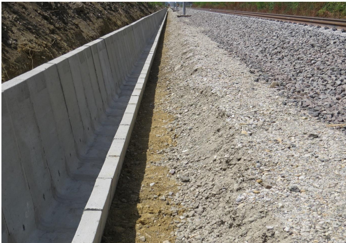
Slika 23. Ugradnja gotovih betonskih kanalice tipa 1, Pružne građevine
