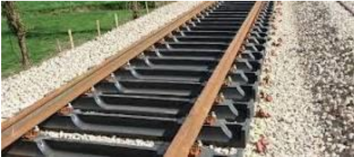
Slika 5. Čelični željeznički pragovi [15]
