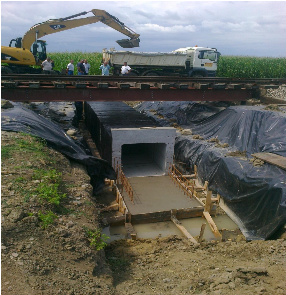
Slika 54. Propust, dionica pruge Vinkovci-Županja, Pružne građevine
