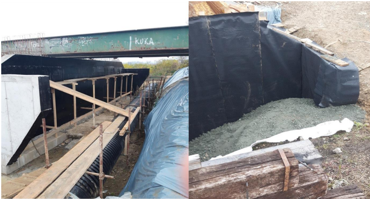
Slika 51. Izolacija mosta, Staro Petrovo Selo, Pružne građevine
