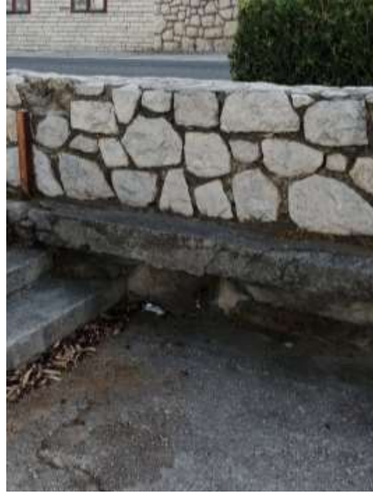
Slika 20: Odvodni kanal na 1,90 mnv
