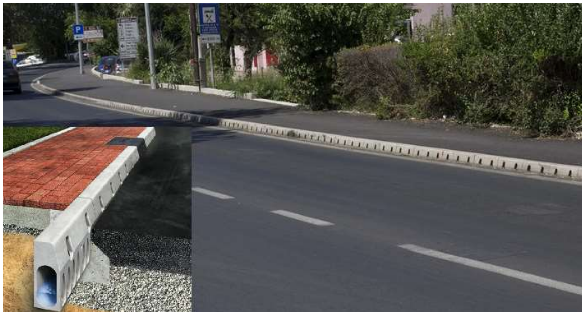
Slika 26: Rubnjak s integriranim linijskim kanalom ( https://www.aco.hr/reference/case-study/dr%C5%BEavna-cesta-d-315-trogir---pantana )
