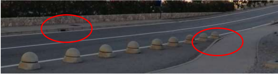
Slika 25: Odvodni rubnjaci na području 2.
