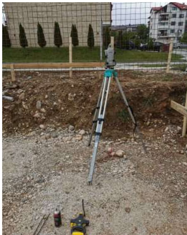
Slika 13. Prikaz nivelira i nanosne skele (Izvor: https://web.facebook.com/geosimsp/posts/3310382052359473:0? , pristup: 17.09.2022.)
