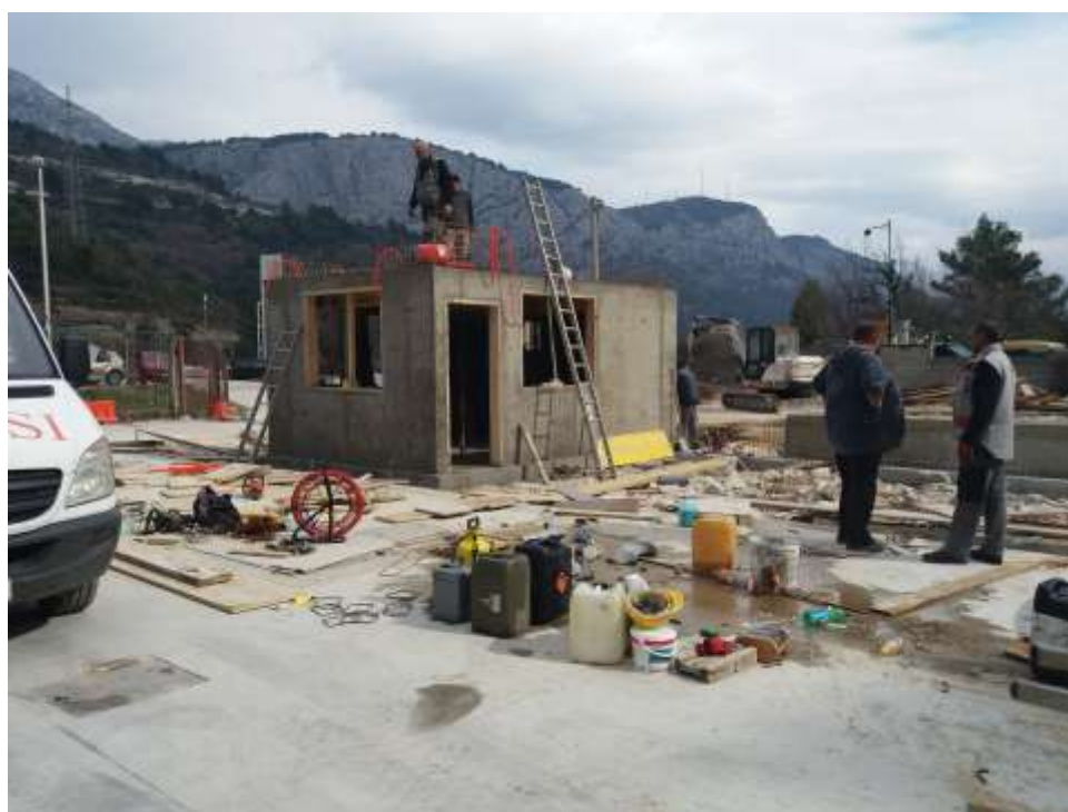
Slika 21. Izrada objekta za zaposlenike sa sanitarnim čvorom i upravljačkom pločom vage i rasvjete( Izvor: Grad Omiš, Upravni odjel za komunalnu i stambenu djelatnost, prostorno uređenje i zaštitu okoliša, pristup rujan 2022.)
