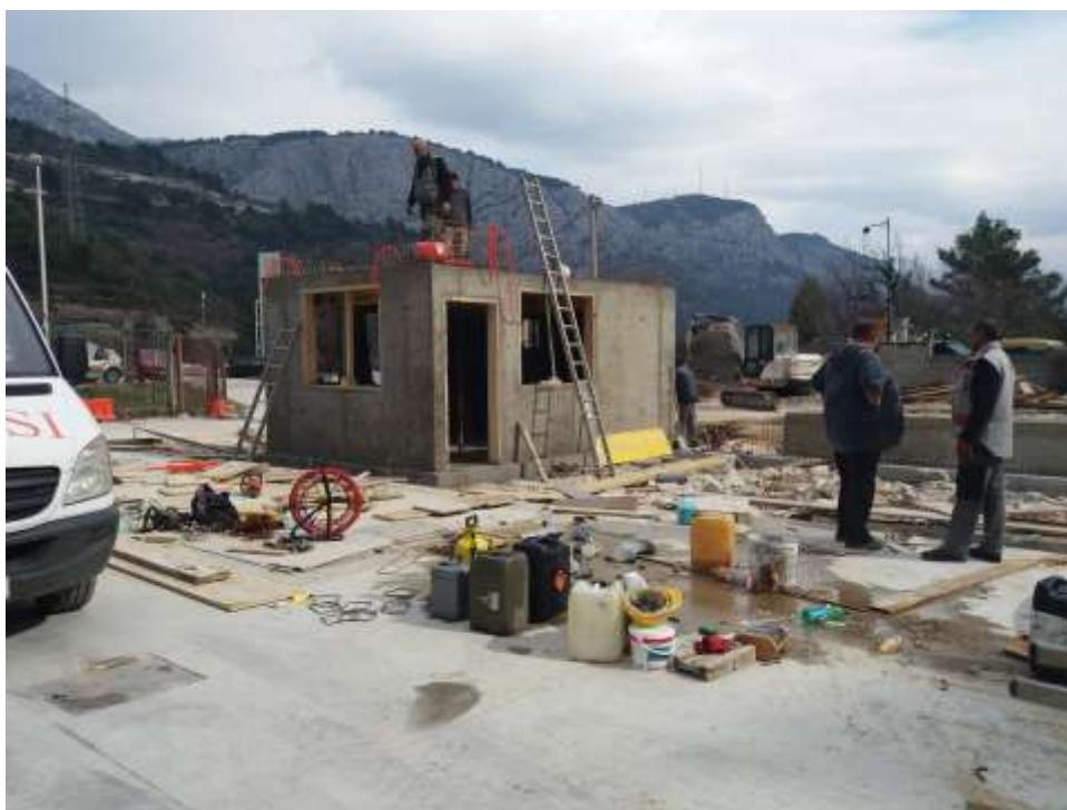
Slika 21. Izrada objekta za zaposlenike sa sanitarnim čvorom i upravljačkom pločom vage i rasvjete( Izvor: Grad Omiš, Upravni odjel za komunalnu i stambenu djelatnost, prostorno uređenje i zaštitu okoliša, pristup rujan 2022.)
