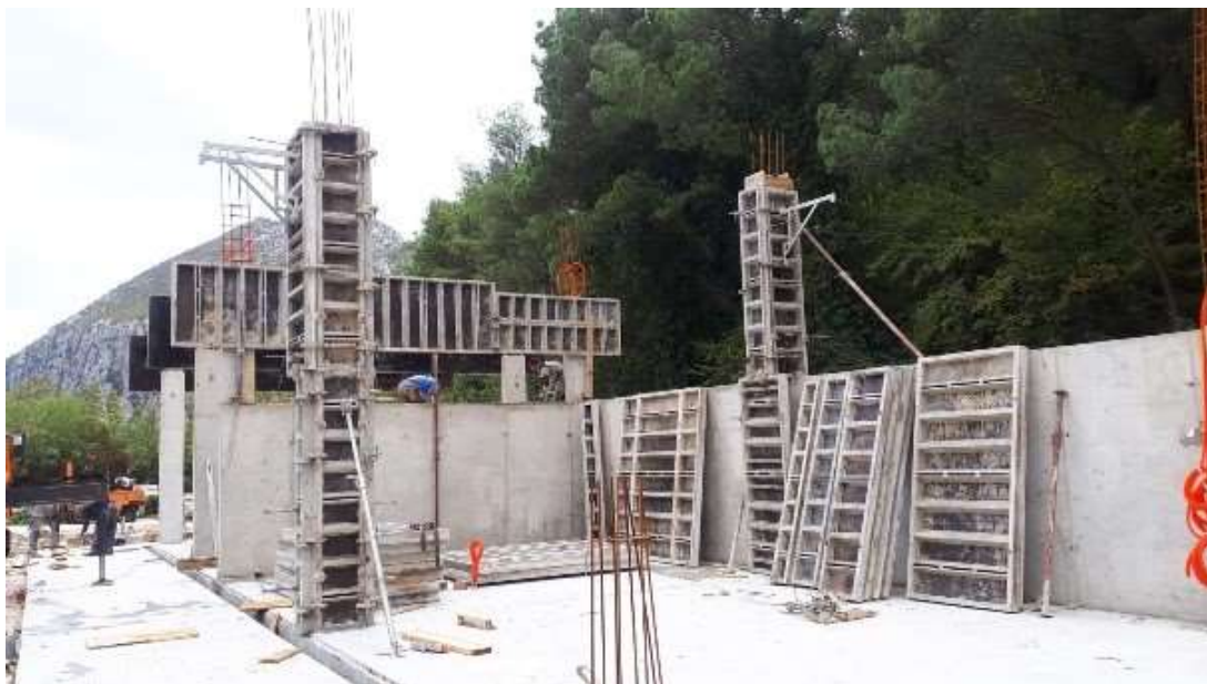
Slika 22. Izrada AB konstrukcije nadstrešnice ( Izvor: Grad Omiš, Upravni odjel za komunalnu i stambenu djelatnost, prostorno uređenje i zaštitu okoliša, pristup rujan 2022.)
