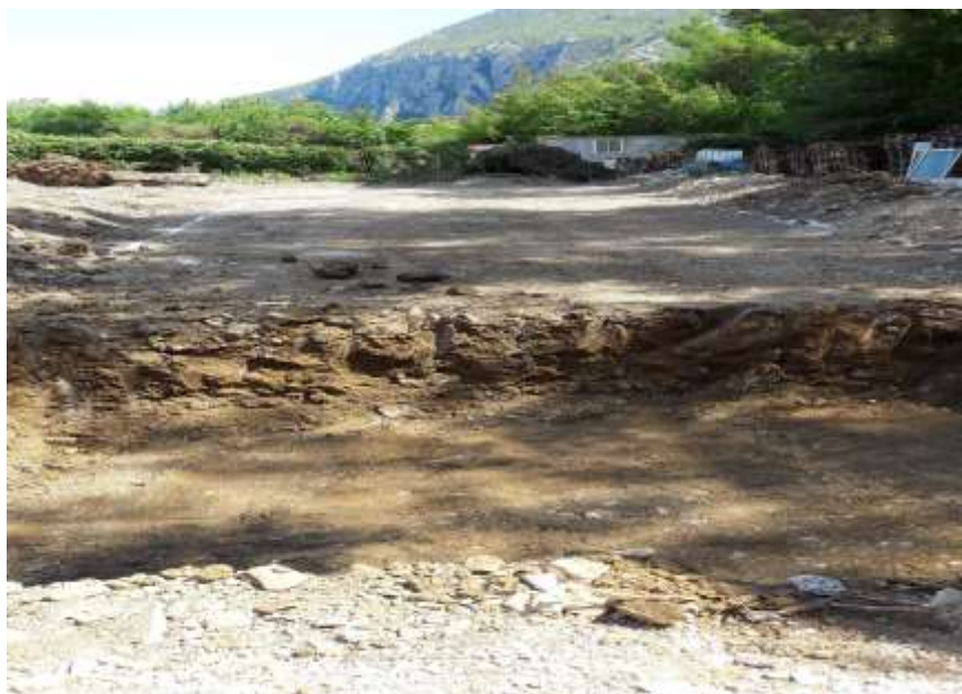
Slika 16. Planiranje i zbijanje dna iskopa ( Izvor: Grad Omiš, Upravni odjel za komunalnu i stambenu djelatnost, prostorno uređenje i zaštitu okoliša, rujun 2022.godine)
