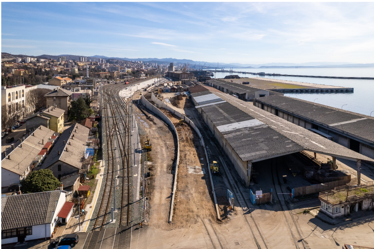
Slika 29: Radovi na izgradnji Spojne ceste lučkog područja sa cestom D 403
