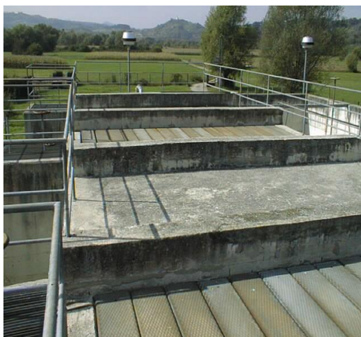
Slika 3: Primarni taložniki i bioeracijski bazen
