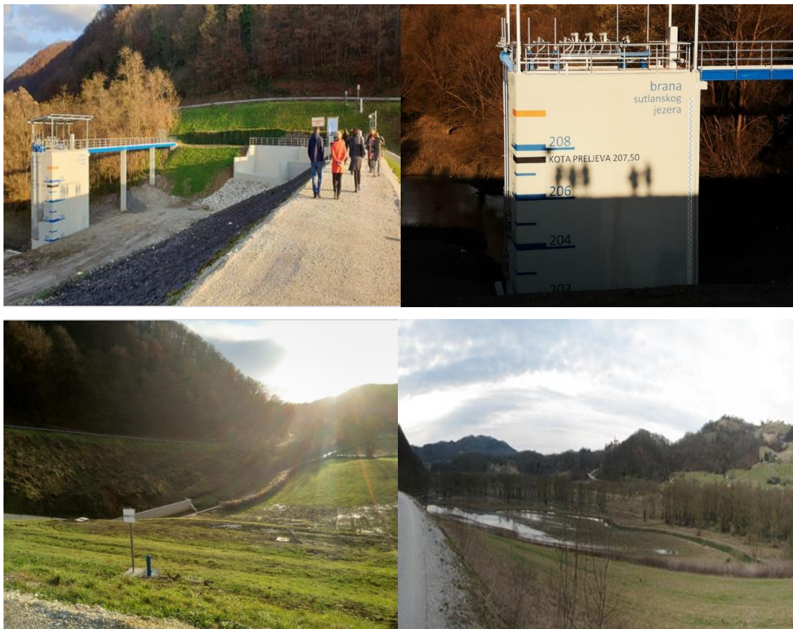
Slika 4 do 7: Slike obnovljene vodne strane brane Vonarje (Project FRISCO 2.1., 2014.-2020.)
