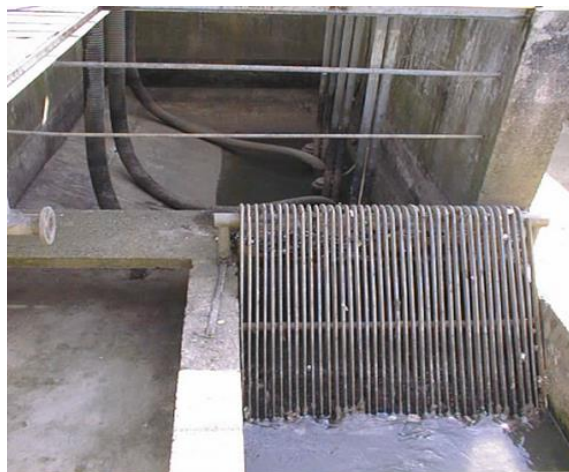
Slika 2: Crpka s rešetkom
