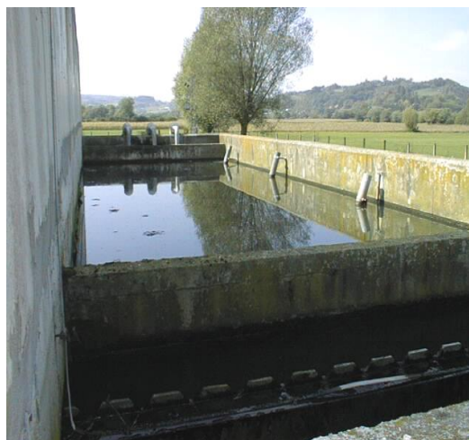
Slika 4: Sekundarni taložnik
