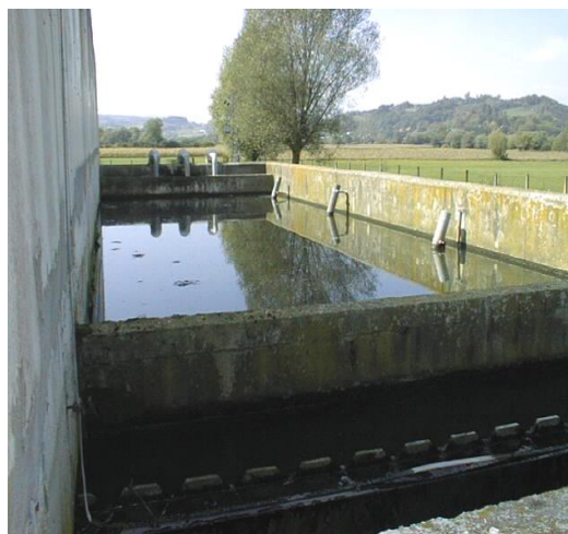
Slika 4: Sekundarni taložnik
