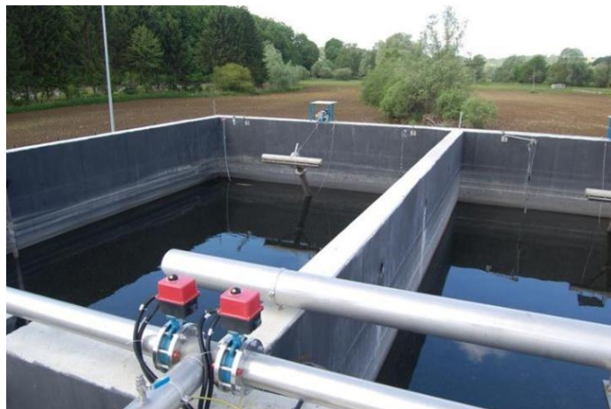
Slika 7: Bioaeracijski bazeni
