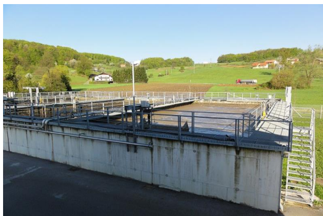
Slika 10: Bioaeracijski bazen
