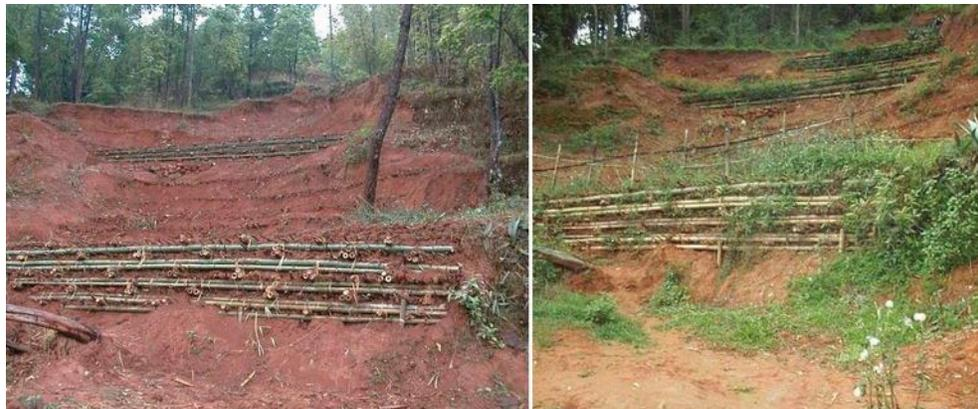
Slika 23: Potporna konstrukcija od bambusa [13]
