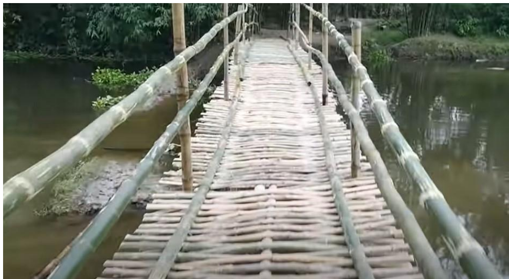
Slika 19: Završni izgled mosta [10]
