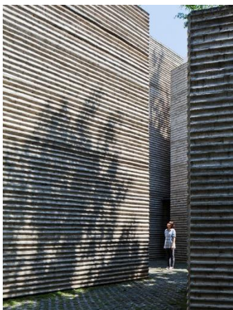
Slika 22: Izgubljena oplata [16]
