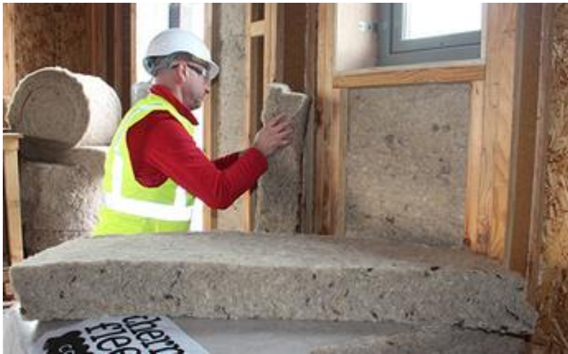
Slika 2. Postavljanje ovčje vune
