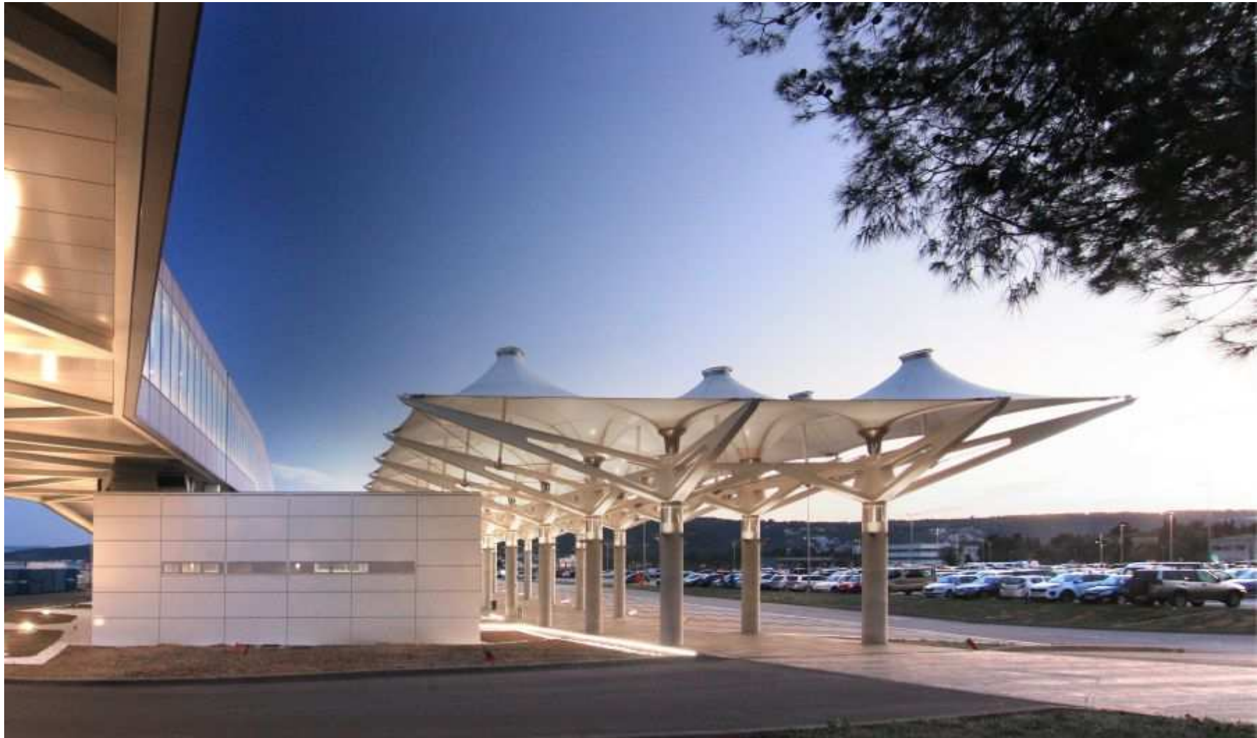
Slika 13: Sjeverno pročelje zgrade B1 i B2 (autobusni terminal i pješački nathodnik)[6]
