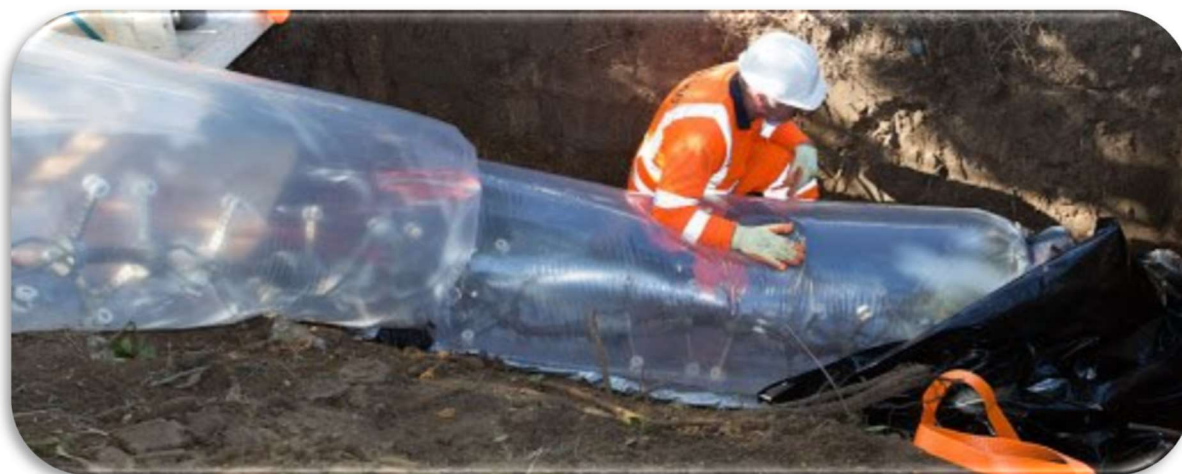
Slika 6 : Postupak ubacivanja CIPP cijevi
