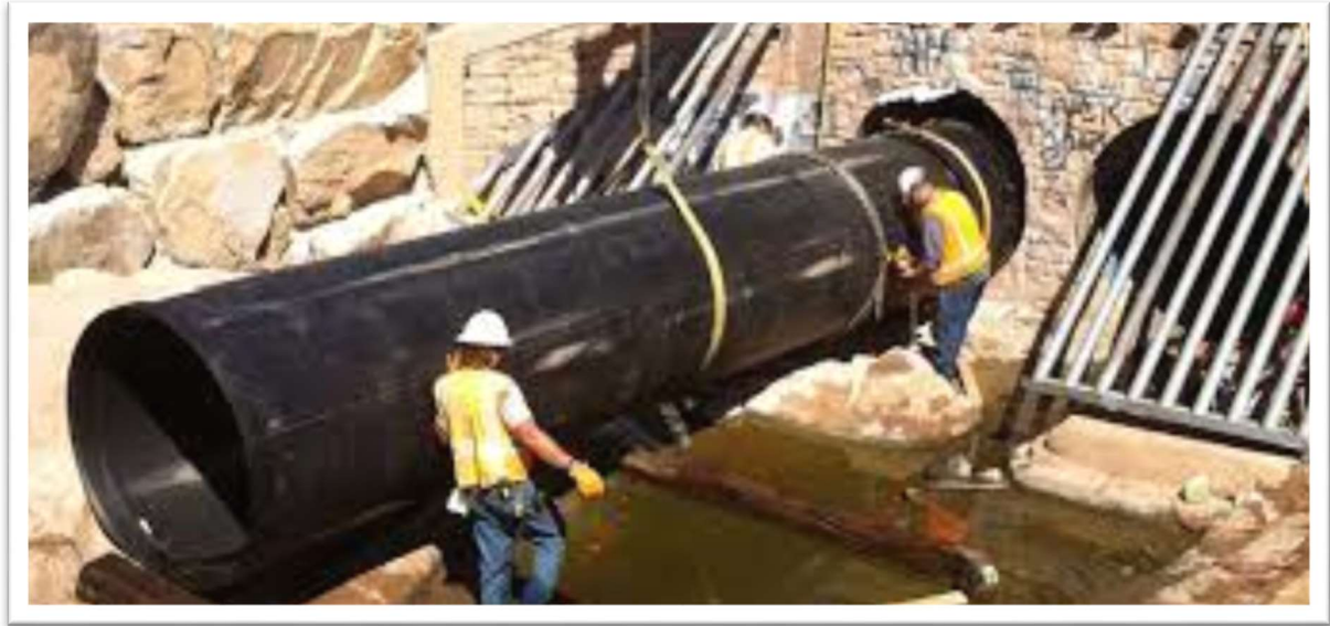
Slika 15 : Metoda klizajuće obloge [14]
