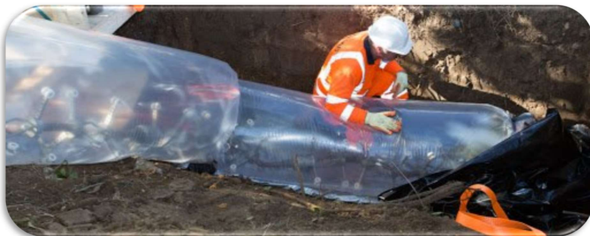
Slika 6 : Postupak ubacivanja CIPP cijevi
