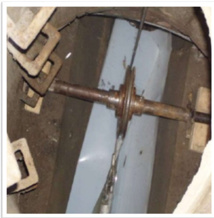
Slika 28 : Vodilica za uvlačenje u početnom oknu [11]
