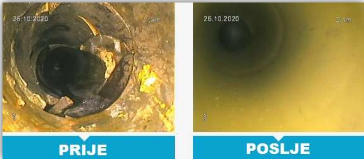
Slika 11 : Prije i poslije sanacije CIPP metodom [13]
