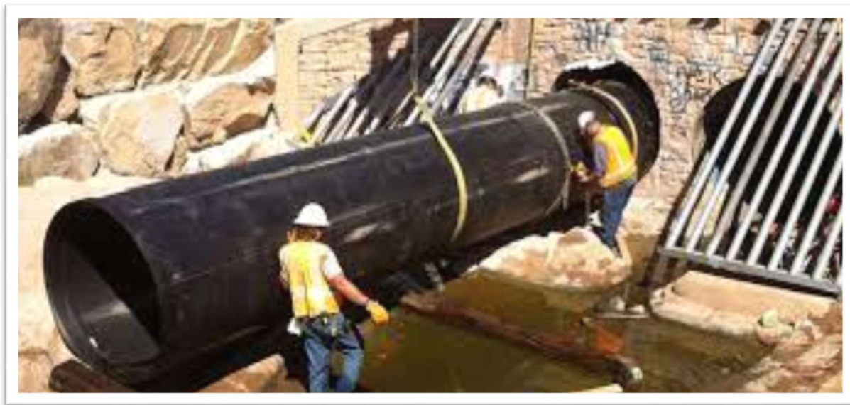
Slika 15 : Metoda klizajuće obloge [14]
