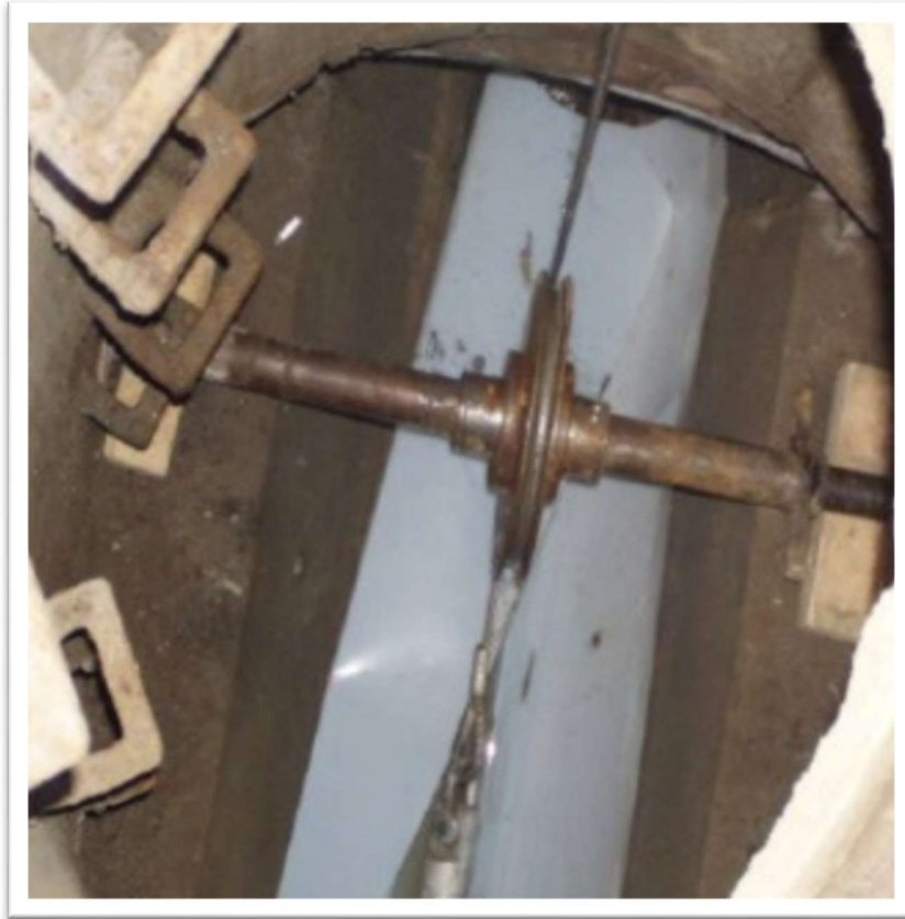
Slika 28 : Vodilica za uvlačenje u početnom oknu [11]
