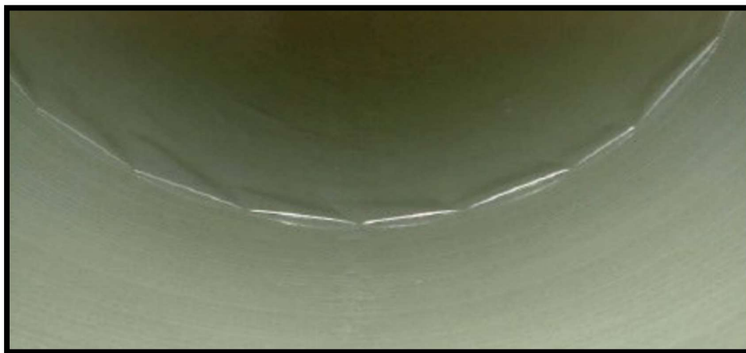
Slika 32 : Uklanjanje unutrašnje zaštitne folije [11]
