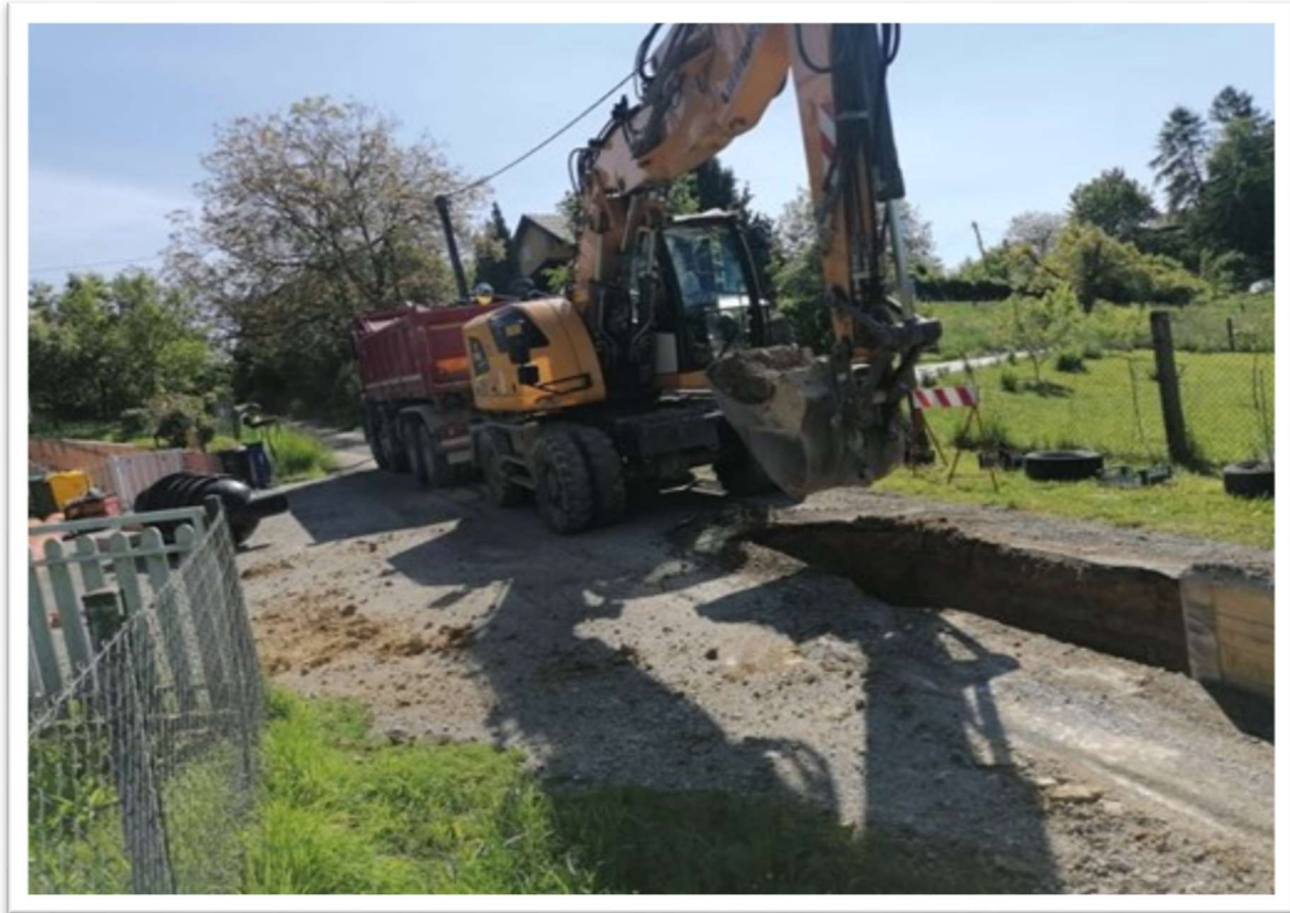
Slika 4 : Iskop kanala za postavljanje cijevi
