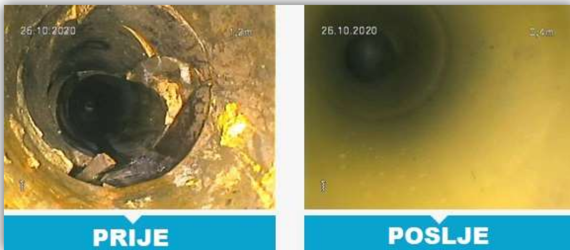
Slika 11 : Prije i poslije sanacije CIPP metodom [13]
