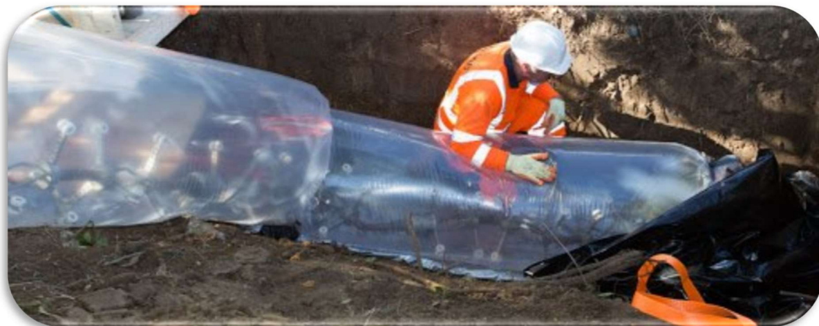
Slika 6 : Postupak ubacivanja CIPP cijevi
