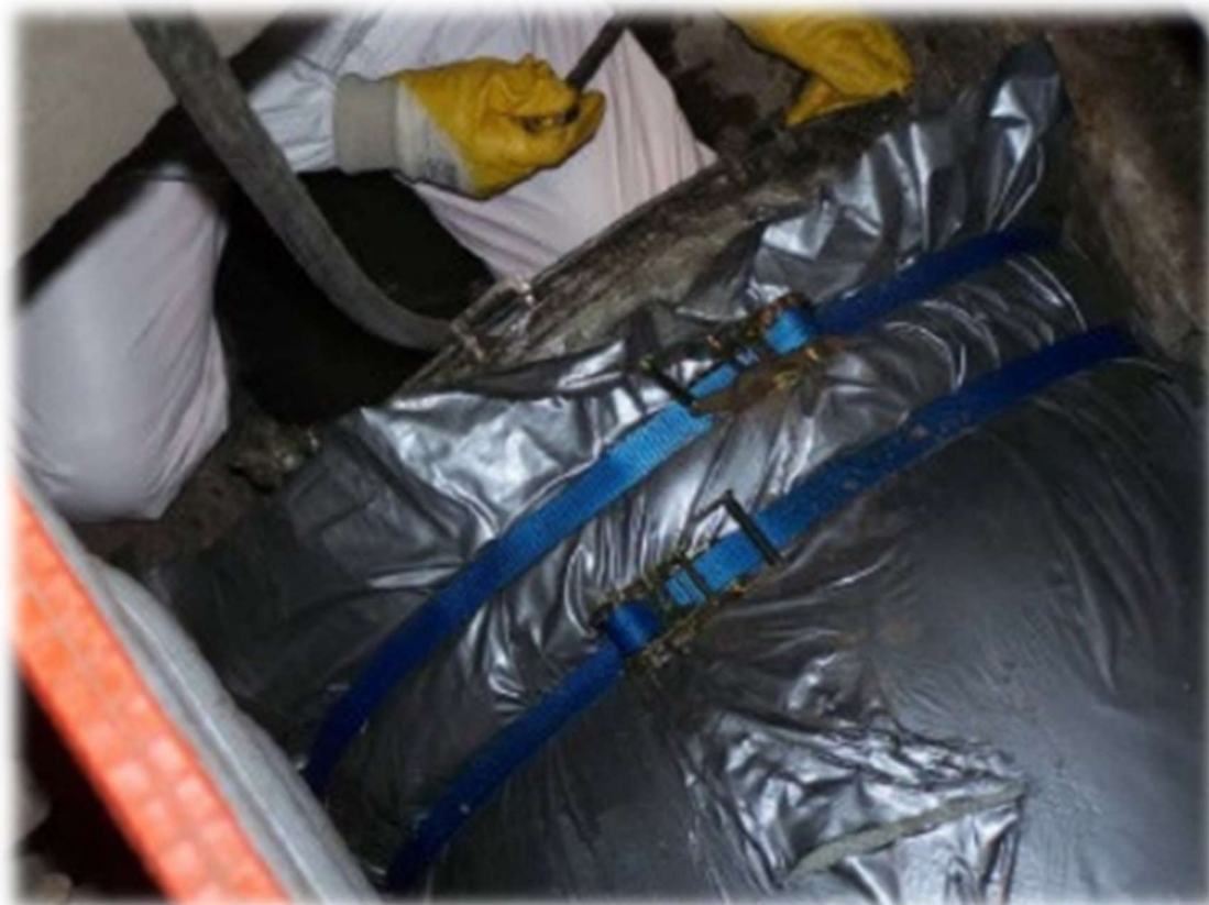
Slika 29: Postavljanje pakera na kraju linera [11]
