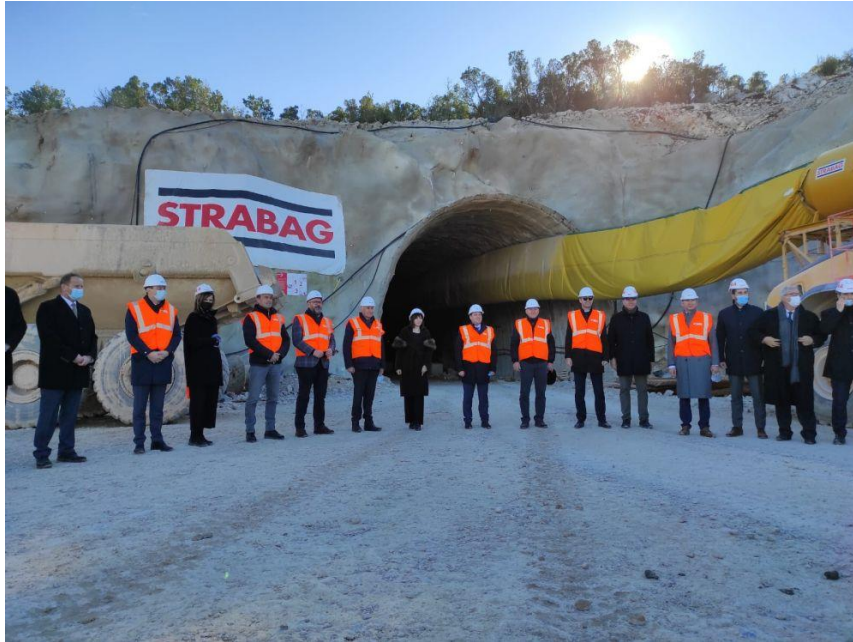
Slika 37. Završetak probijanja tunela [22]
