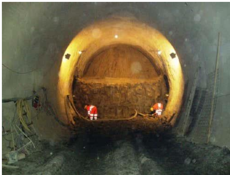
Slika 32. Iskop u dvije faze [4]
