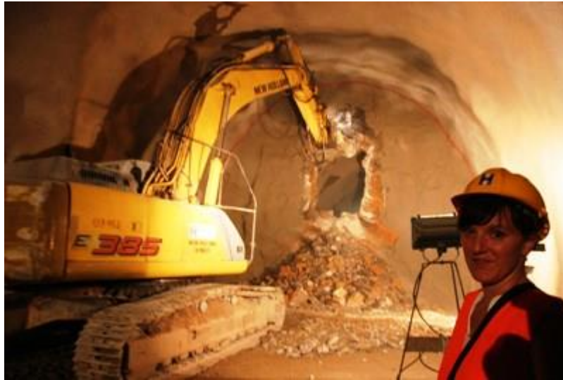
Slika 5. Iskop tunela bagerom [21]
