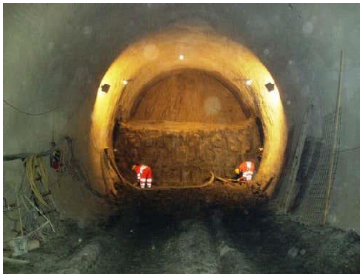
Slika 32. Iskop u dvije faze [4]
