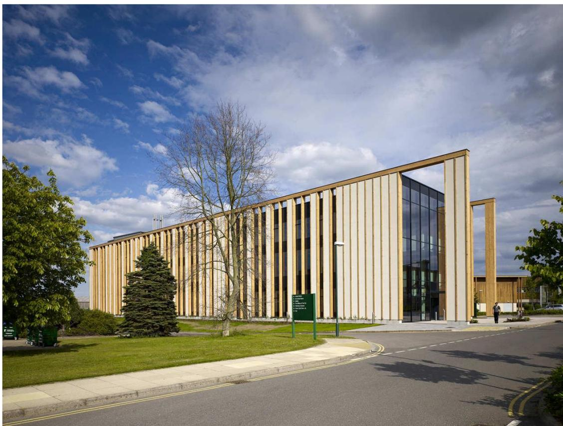
Zgrada sveučilišta prikazana na slici izgrađena je 2011. godine u Nottinghamu. Projektirali su je arhitekti ureda Make Architects. U ovome projektu komprimirana slama je korištena u svrhu ispune panela dugih 14 metara napravljenih od križno lameliranog drva, pridajući im toplinsku i zvučnu izolaciju (slika 11). S vanjske strane slama je zaštićena vodonepropusnom žbukom kako bi se zadržala njezina svojstva. Iskoristivost
