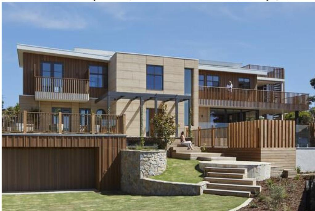
Ova obiteljska kuća izgrađena je u Moonah, Australija, u 2023. godini. Projektirali su je arhitekti ureda Kirby Architects [42]. Vanjski zidovi su napravljeni od nabijene zemlje, pružajući ugodnu atmosferu unutarnjeg prostora. Ostali nosivi elementi, poput stubišta, napravljeni su od drva, te pružaju potrebnu nosivost konstrukciji, čineći zajednički sa nabijenom zemljom ekološki održivu građevinu.
