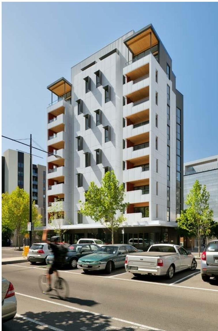
Slika prikazuje deseterokatnu stambenu zgradu u Brisbanu, Australija, izgrađenu od križno lameliranog drva „CLT“. Projektirao ju je arhitekt Andrew Nieland, a izgrađena 2012 godine. Ova vrsta drvene građe izrađena je od tankih drvenih panela, debljine oko 20 milimetara, spojenih kako bi tvorili slojeve. Svaki panel se postavlja okomito na prethodni kako bi se poboljšala njihova svojstva. Podne ploče prvih dviju etaža građevine
