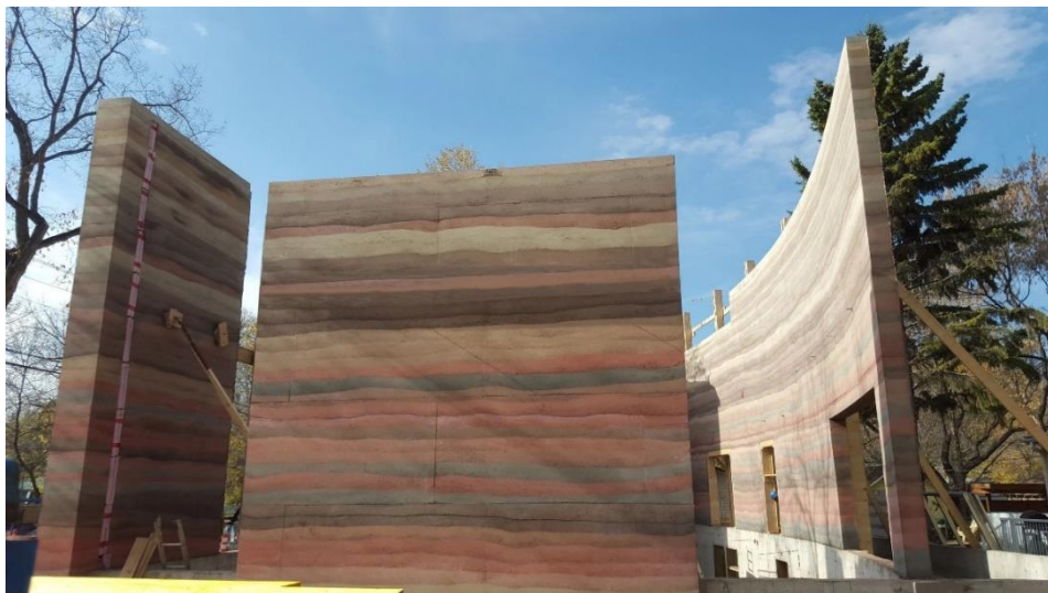
Slika 16: prikaz raznolikosti boja zida od nabijene zemlje [42]
