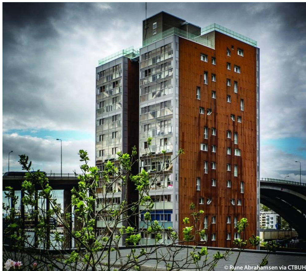
Slika 2: Stambena zgrada „Treet“ u Bergen, Norveška [10]
