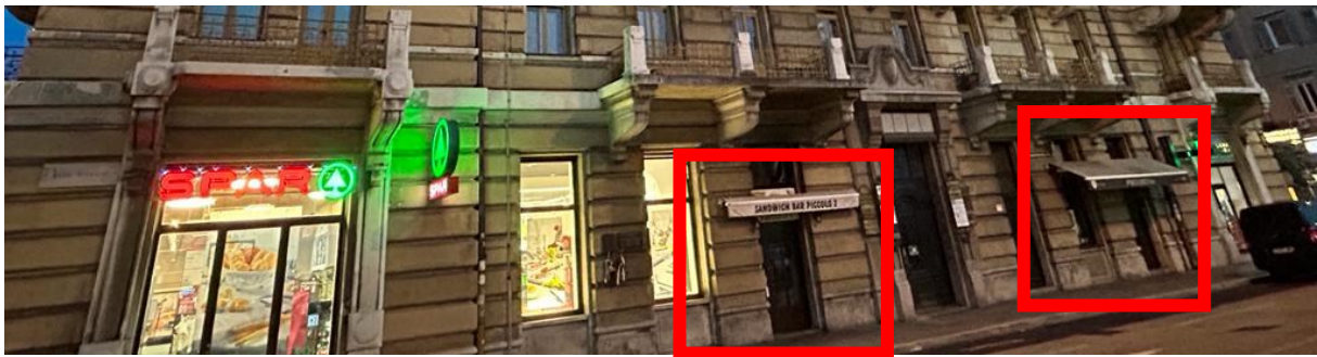
Slika 16 Objekti u prizemlju zapadnog pročelja (izradio autor)
