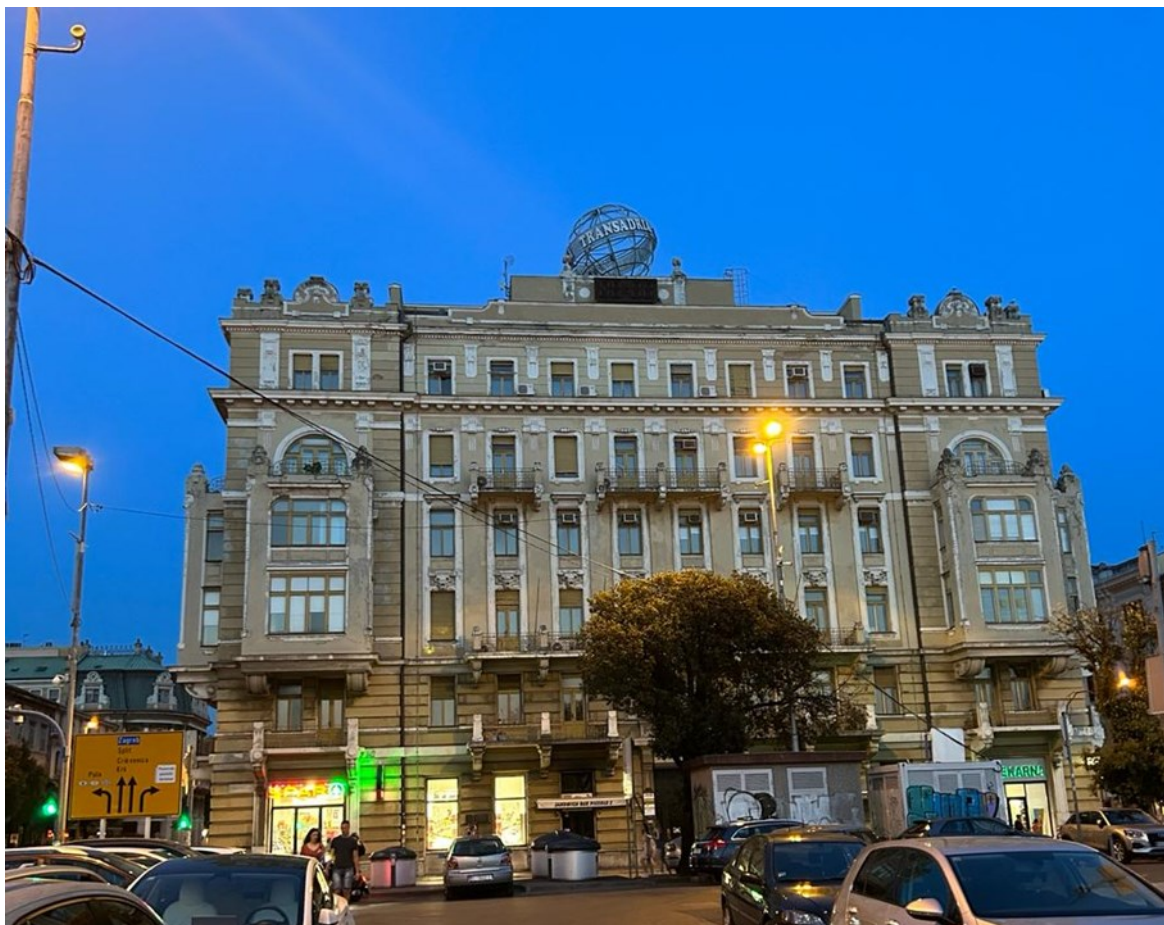
Slika 7 Pogled na zapadno pročelje (izradio autor)
