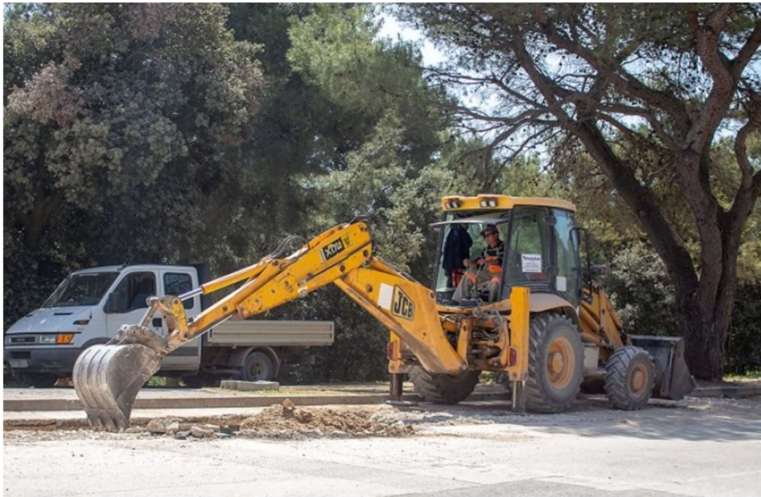
Slika 24 Radovi na sanaciji u ulici Verudela [33]
