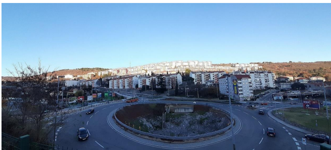
Slika 5. Uklapanje kružnog raskrižja u prostor i iskorištavanje središnjeg otoka za potrebe retencije [6]
