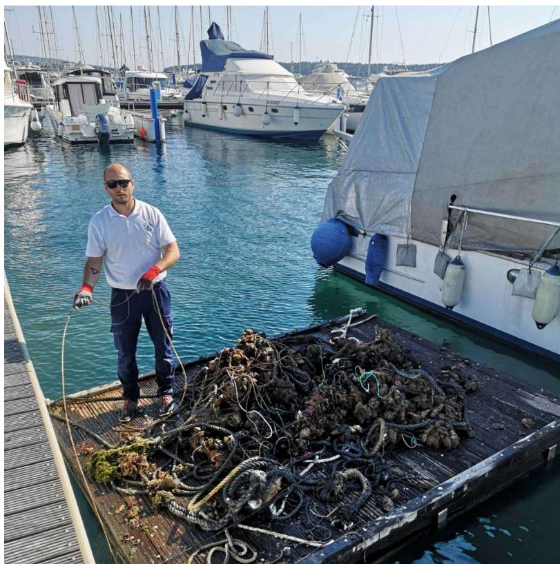
Slika 83: Prikazuje redovitu izmjenu privezanih konopaca (foto autor)
