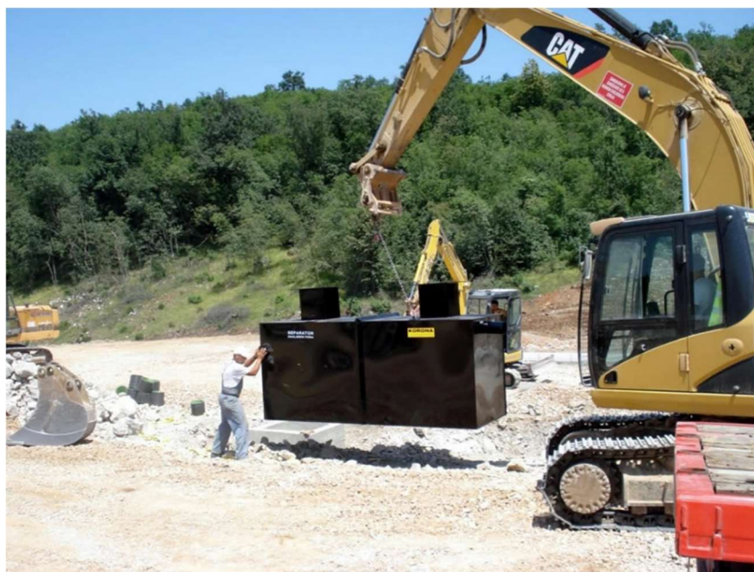
Slika 82: Prikazuje ugradnju separatora [20]
