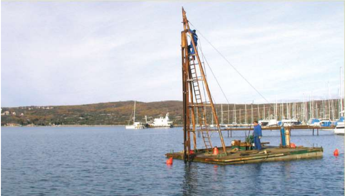
Slika 33: Ponton s “makarom“ za zabijanje pilona [3]
