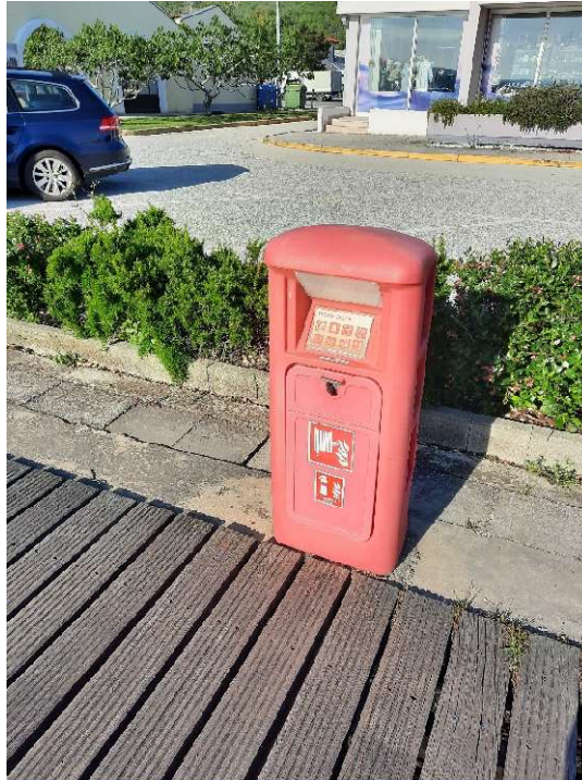
Slika 2: Ormarić za opskrbu pitkom vodom i vatrogasni ormarić, Marina Punat (foto autor)
