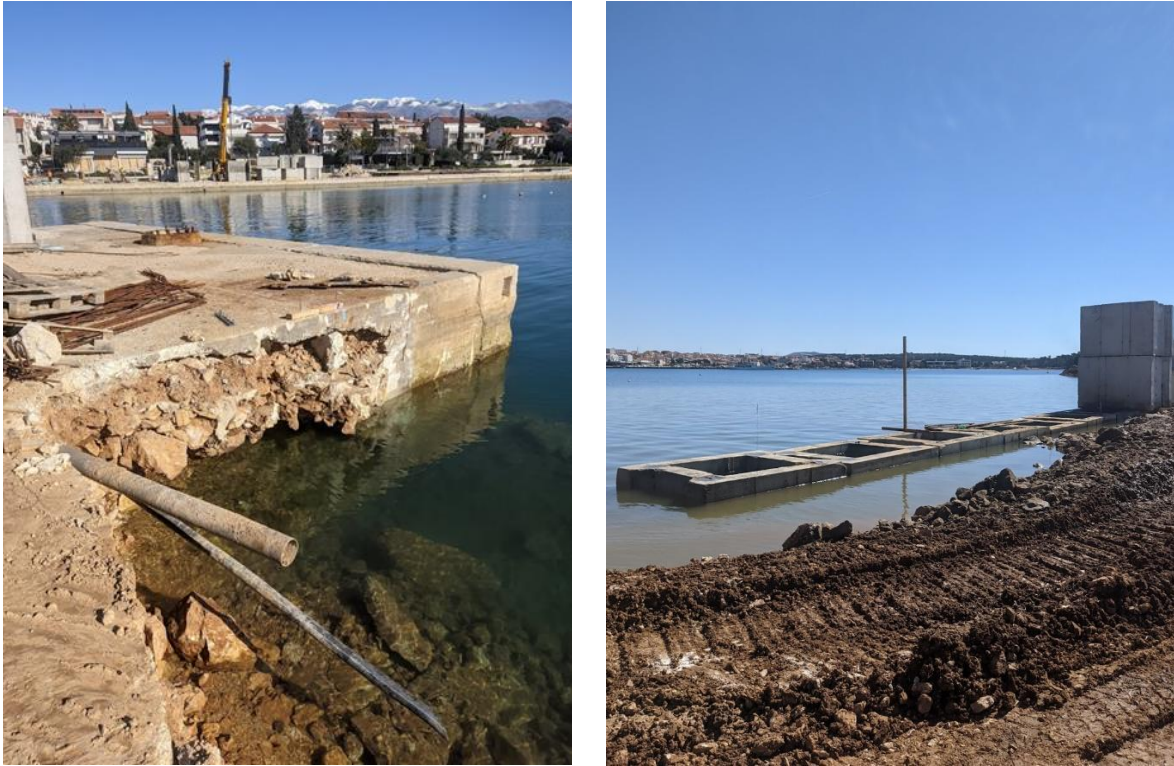
Slika 10. a) Rekonstrukcija obalnog zida (lijevo), b) Dogradnja novog dijela (desno) (izvor: vlastita fotografija)
