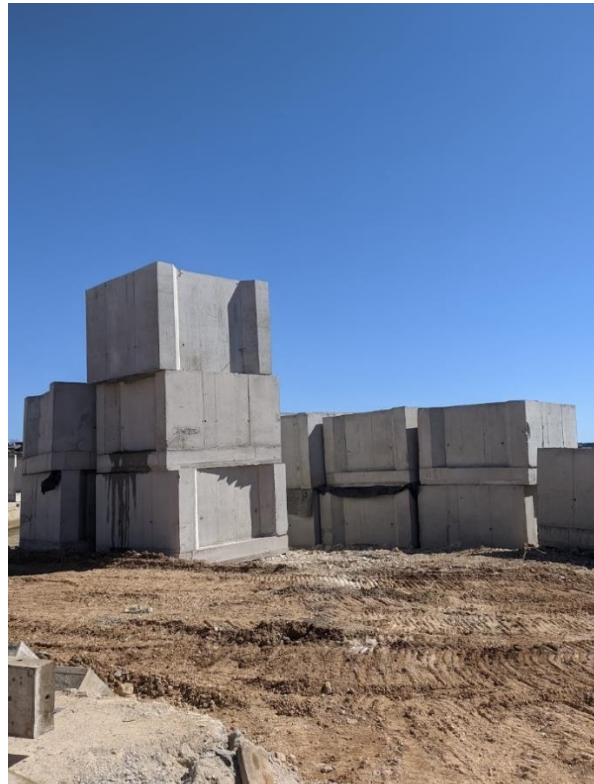
Slika 11. a) Betoniranje AB elemenata, b) Gotovi AB elementi za izvedbu obalnih zidova (izvor: vlastita fotografija)
