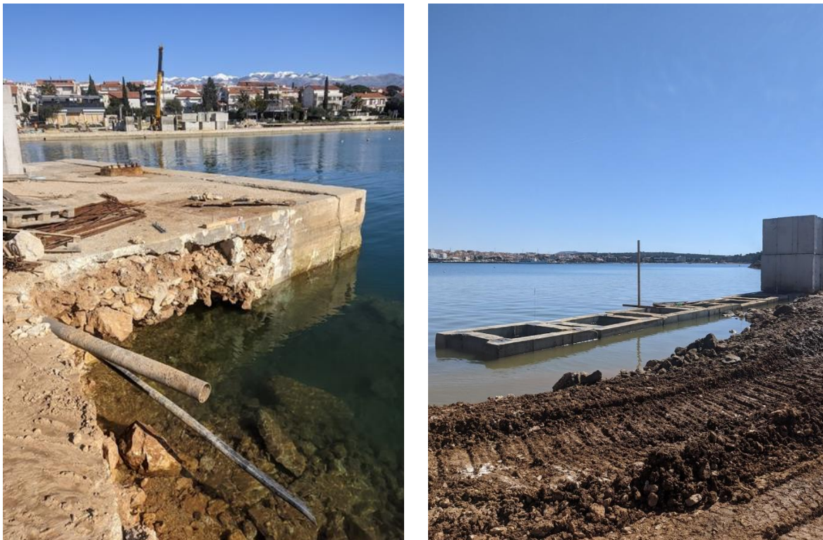
Slika 10. a) Rekonstrukcija obalnog zida (lijevo), b) Dogradnja novog dijela (desno) (izvor: vlastita fotografija)
