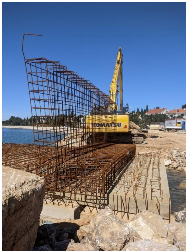
Slika 12. Armatura parapetnog zida (izvor: vlastita fotografija)
