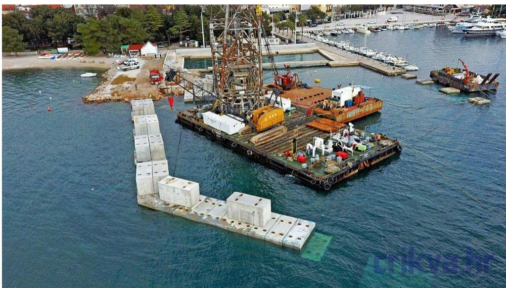
Slika 34: Izgradnja novog vertikalnog lukobrana u Crikvenici (Izvor:
