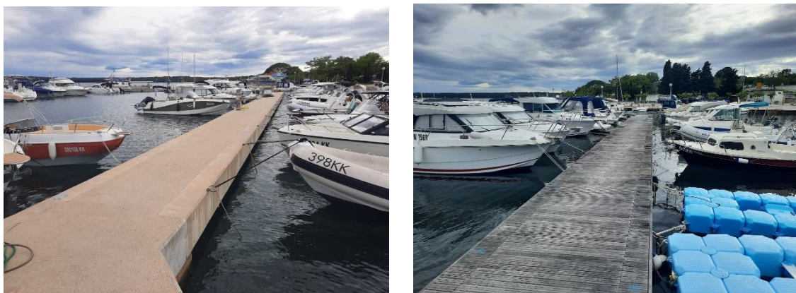
Slike 17 i 18: Primjer gata na pilotima s AB rasponskom konstrukcijom i pontonskog gata, luka Dunat (foto: autor)
