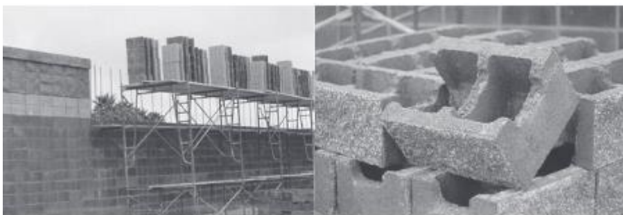
Slika 20: Zidane zvučne barijere [21]
