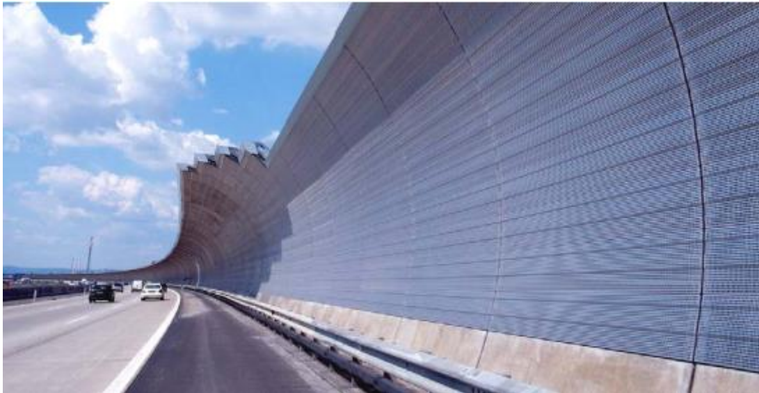
Slika 17: Savijena čelična zvučna barijera
