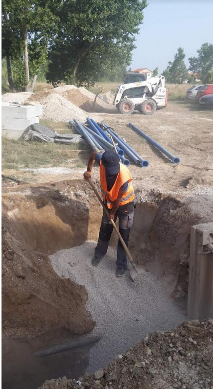
Slika 20. Pripremni radovi za polaganje cijevi na dionici Privlaka (Marko Dujić)
