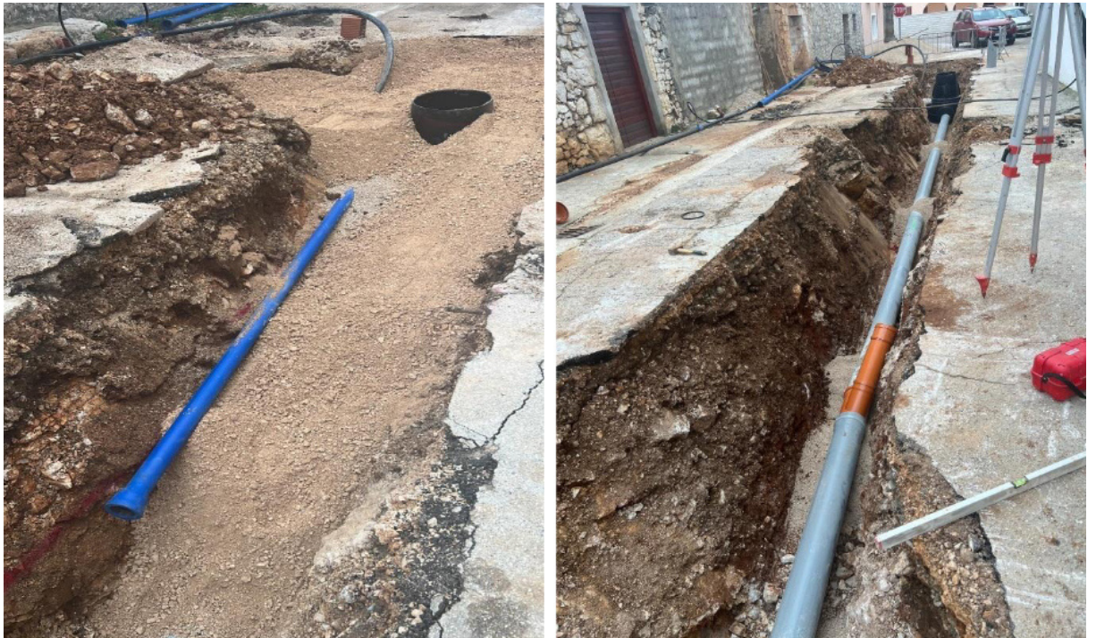
Slika 25. Polaganje vodovodnih cijevi u Zatonu (Marko Dujić)
