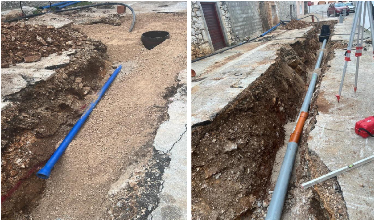
Slika 25. Polaganje vodovodnih cijevi u Zatonu (Marko Dujić)
