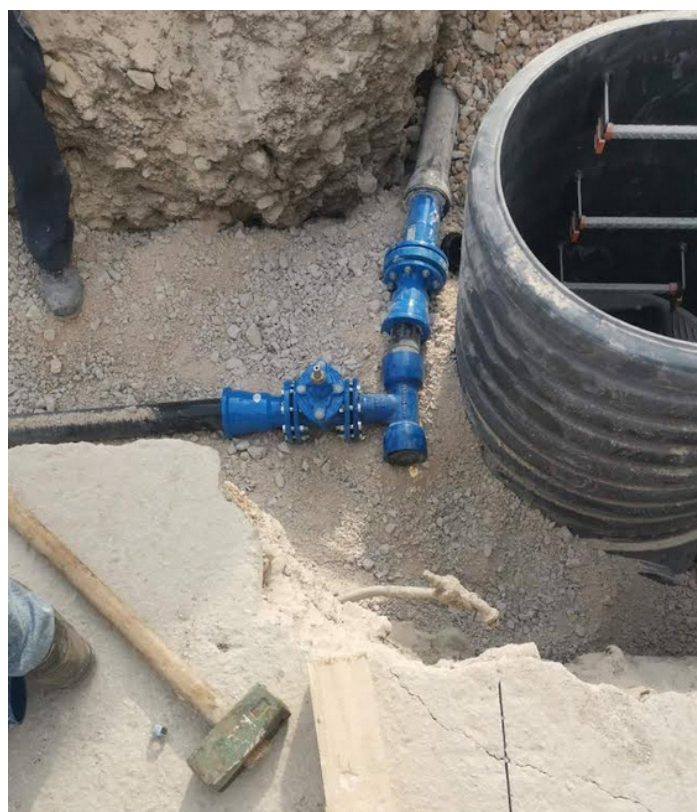
Slika 17. Čvor vodovoda na dionici Privlaka ( Marko Dujić)
