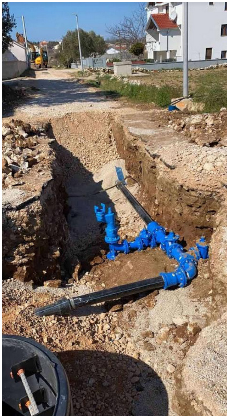
Slika 18. Radovi na vodovodu na dionici Privlaka (Marko Dujić)
