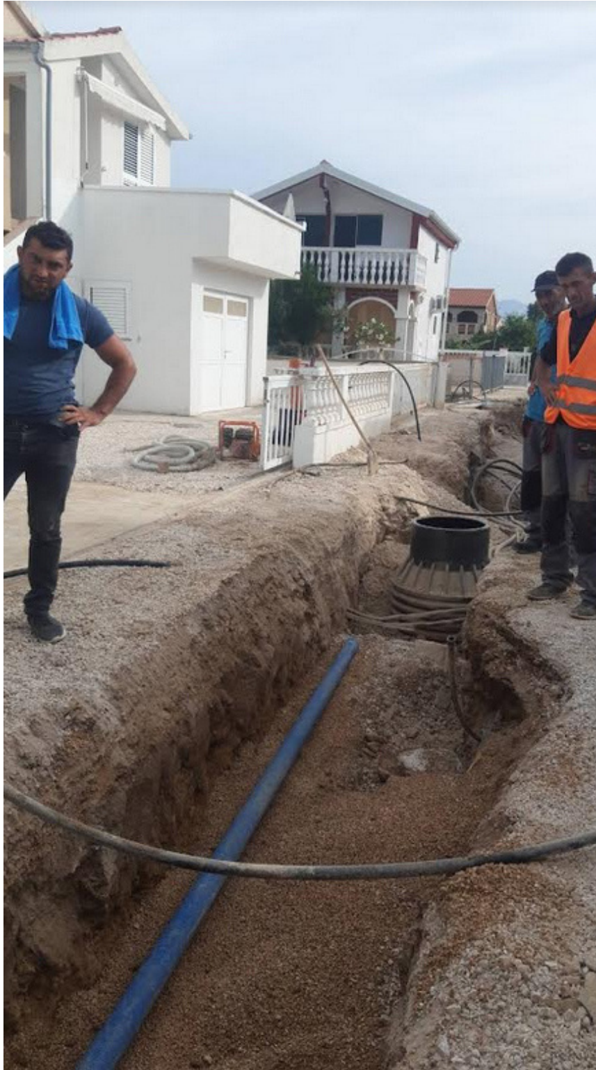
Slika 21. Rekonstrukcija vodovoda na dionici Privlaka (Marko Dujić)
