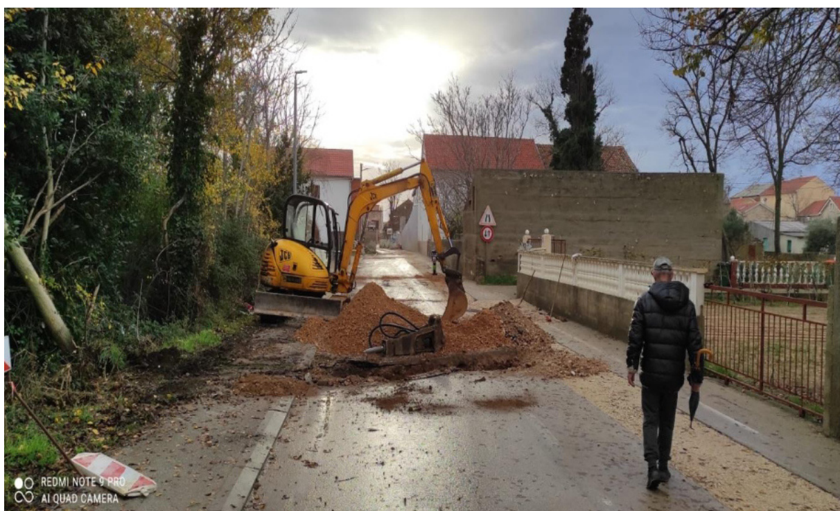
Slika 23. Strojni iskop rova za kućni priključak (Marko Dujić)
