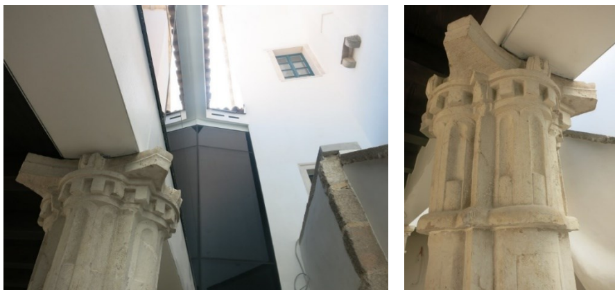
Slika 8. Kapitel stupa nakon sanacije [10]
