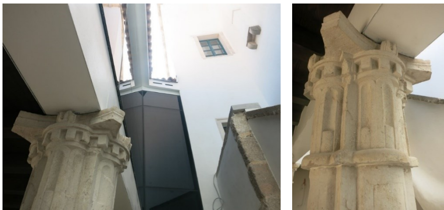
Slika 8. Kapitel stupa nakon sanacije [10]
