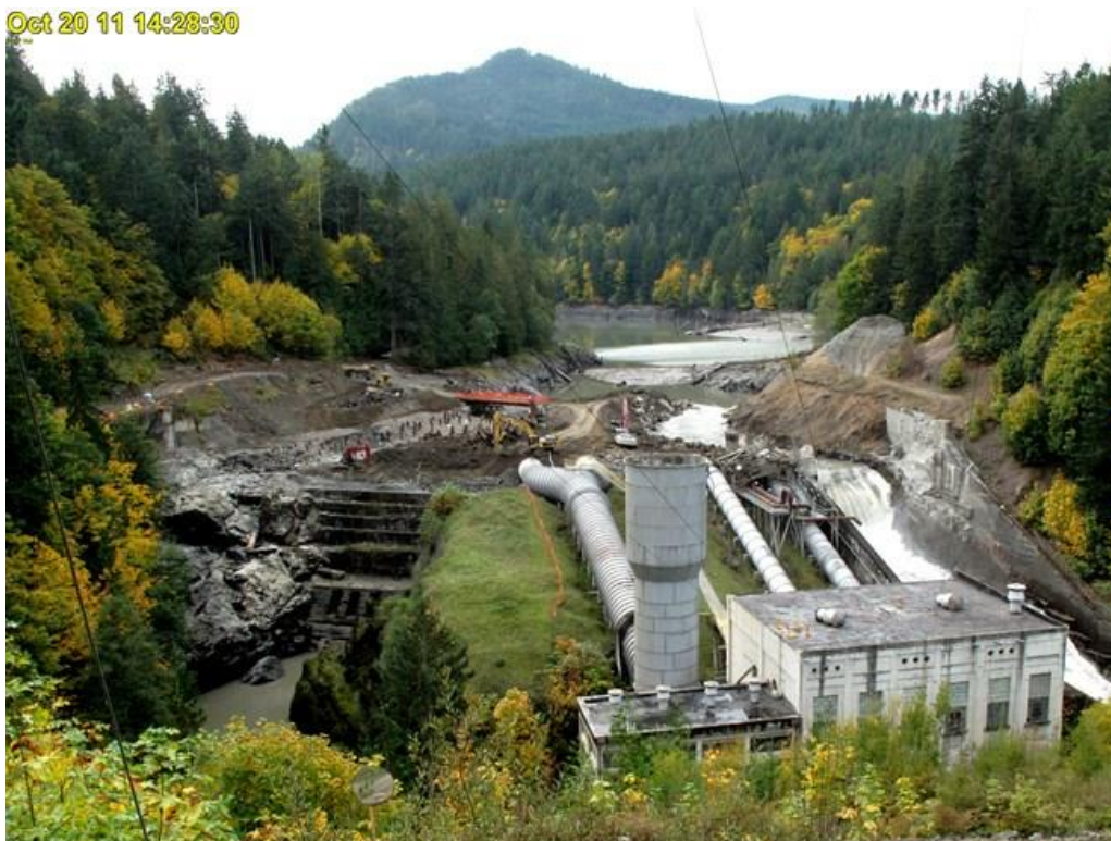
Slika 28: Uklanjanje brane Elwha [36]
