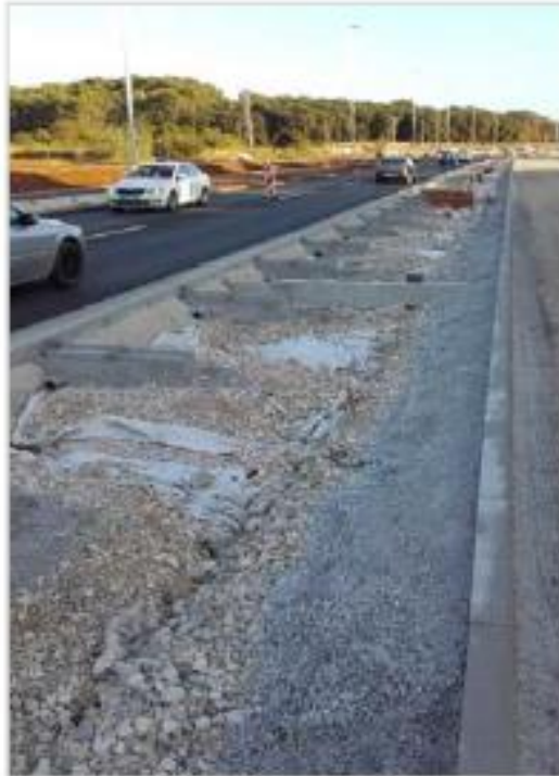
Slika 49: Izgradnja infiltracijskog jarka u razdjelnom pojasu obilaznice grada Pule [52]
