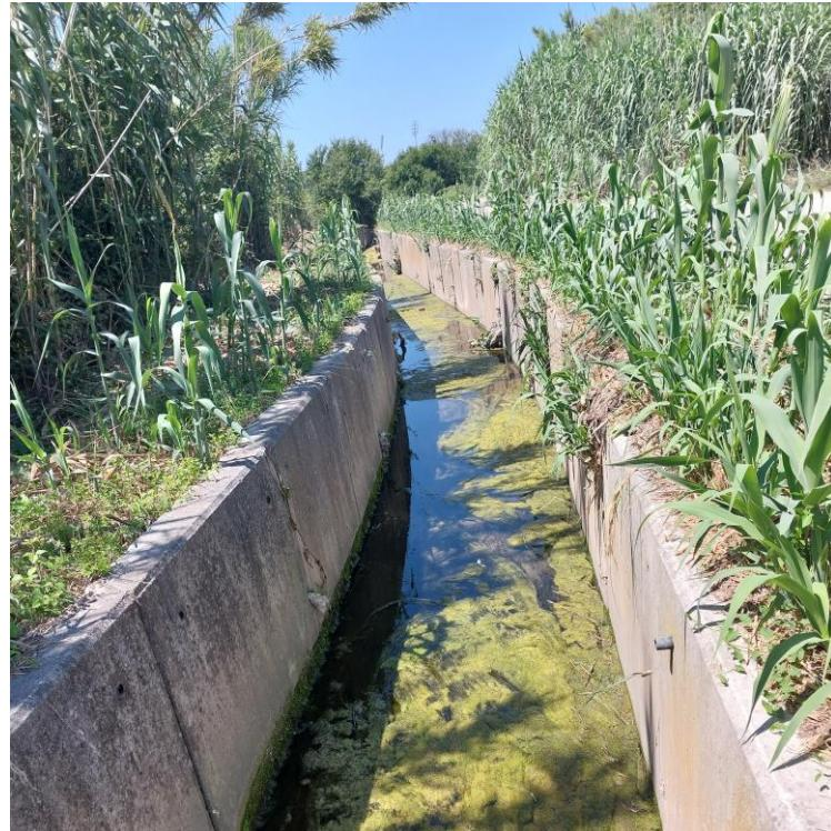
Slika 75: Odvodni kanal obrastao bujnom vegetacijom trske [fotografija: autor, 15.07.2023.]
