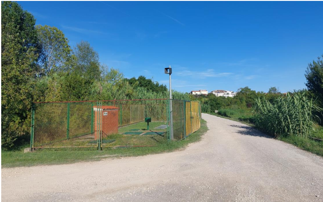
Slika 73: Crpna stanica [fotografija: autor, 15.07.2023.]
