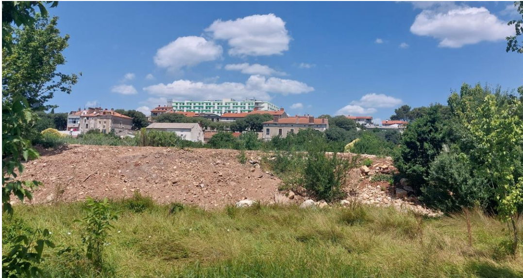
Slika 71: Nasip platoa pored multifunkcionalnog igrališta [fotografija: autor, 15.07.2023.]
