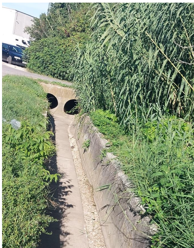
Slika 80: Odvodni kanal na kraju obuhvata [fotografija: autor, 15.07.2023.]
