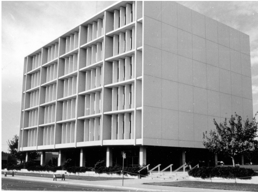
Slika 2.7: Zgrada Imperial County Service, El Centro, Kalifornija 1979. god. [7]
