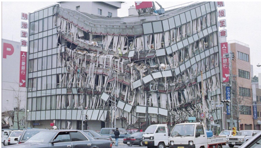
Slika 2.6: Teško oštećena zgrada, potres Kobe, Japan 1995. god., Katsumi Kasahara / Novinar [6]
