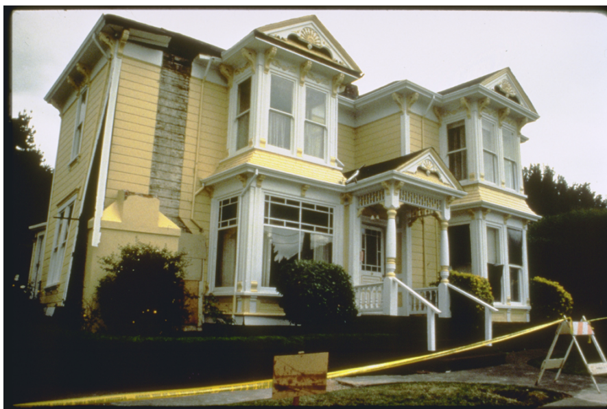
Slika 2.9: Oštećena viktorijanska kuća, Fernadel, Kalifornija, 1992. god. [9]
