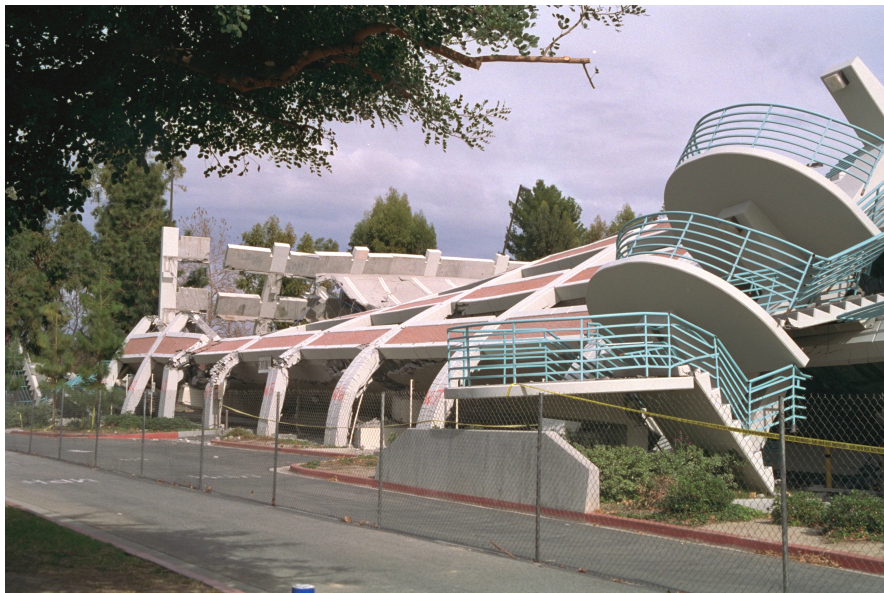
Slika 2.5: Oštećena garaža, potres Northridge, USA 1994. god. [5]
