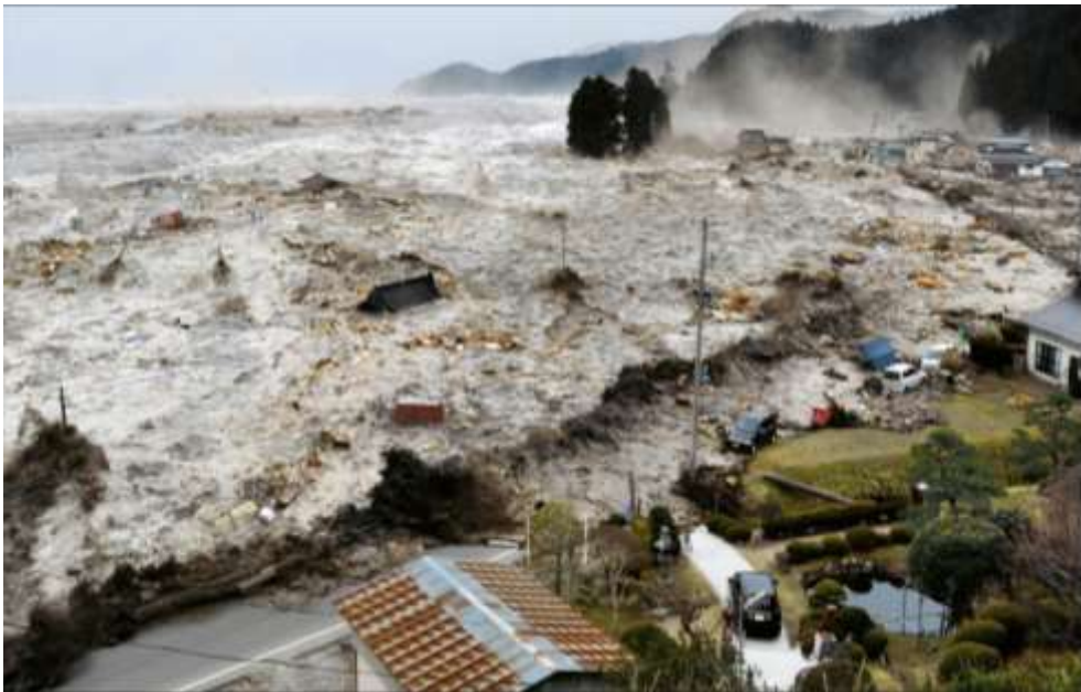
Slika 10. Utjecaj tsunamija na građevine [8]
