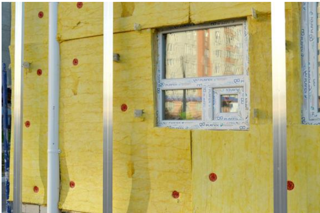
Slika 2: Toplinska izolacija građevine [6]
