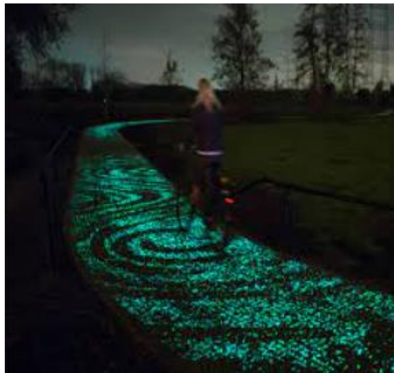
Slika 26 Biciklistička staza napravljena od fotoluminiscentnog betona[11]
