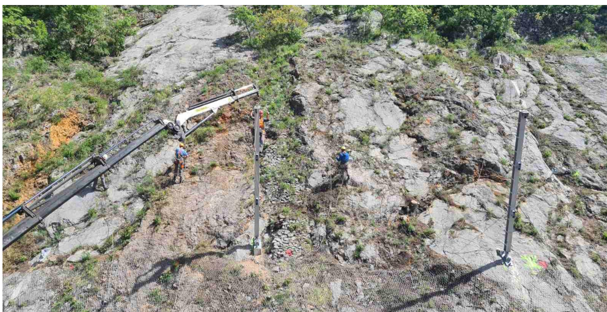
Slika 20. Postavljanje stupova barijere za zaštitu od odrona
