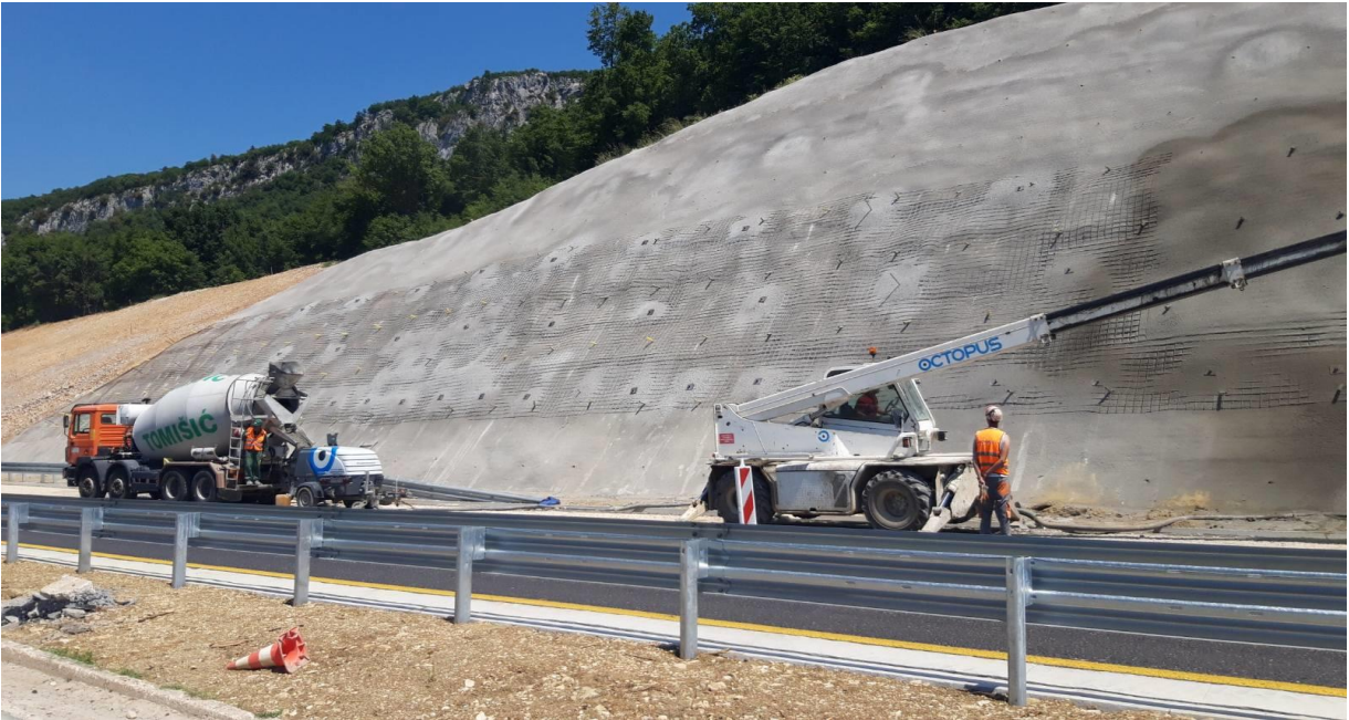
Slika 34. Automiješalica, pumpa za mlazni beton i manipulator
