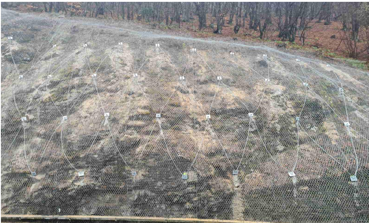
Slika 14. Kabelska nosiva mreža sa sekundarnom heksagonalnom mrežom
