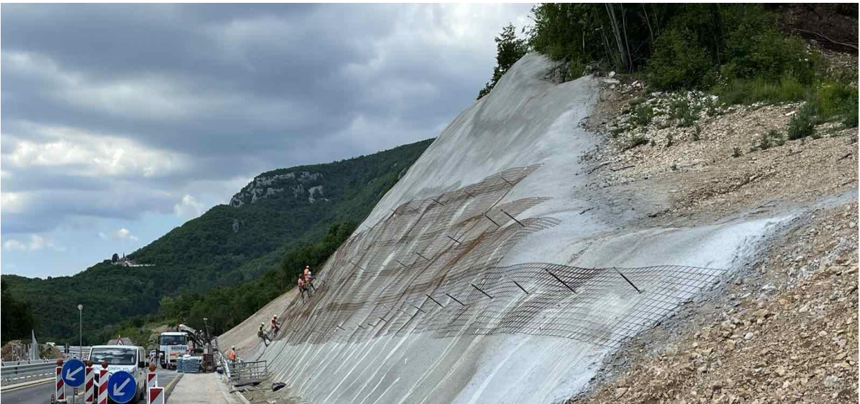
Slika 4. Geotehnička sidra u mlaznom betonu
