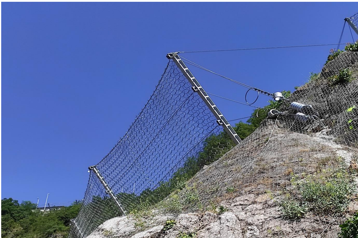
Slika 19. Barijera za zaštitu od odrona
