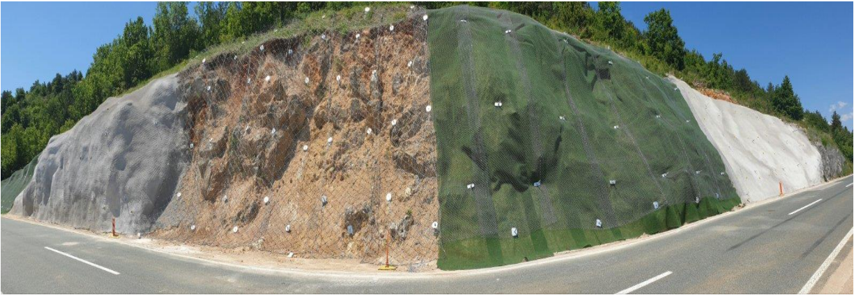
Slika 2. Zaštita pokosa kombinacijom nekoliko sustava zaštite
