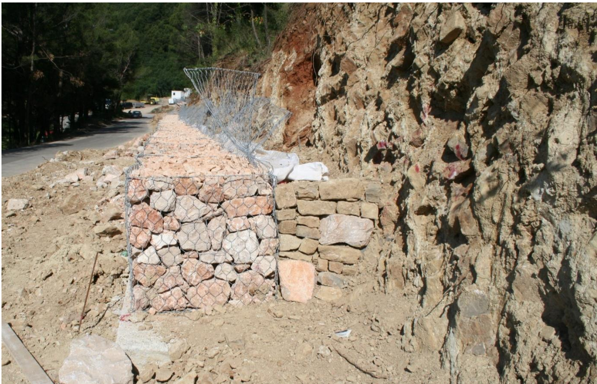
Slika 23. Punjenje gabionskih koševa kamenim materijalom
