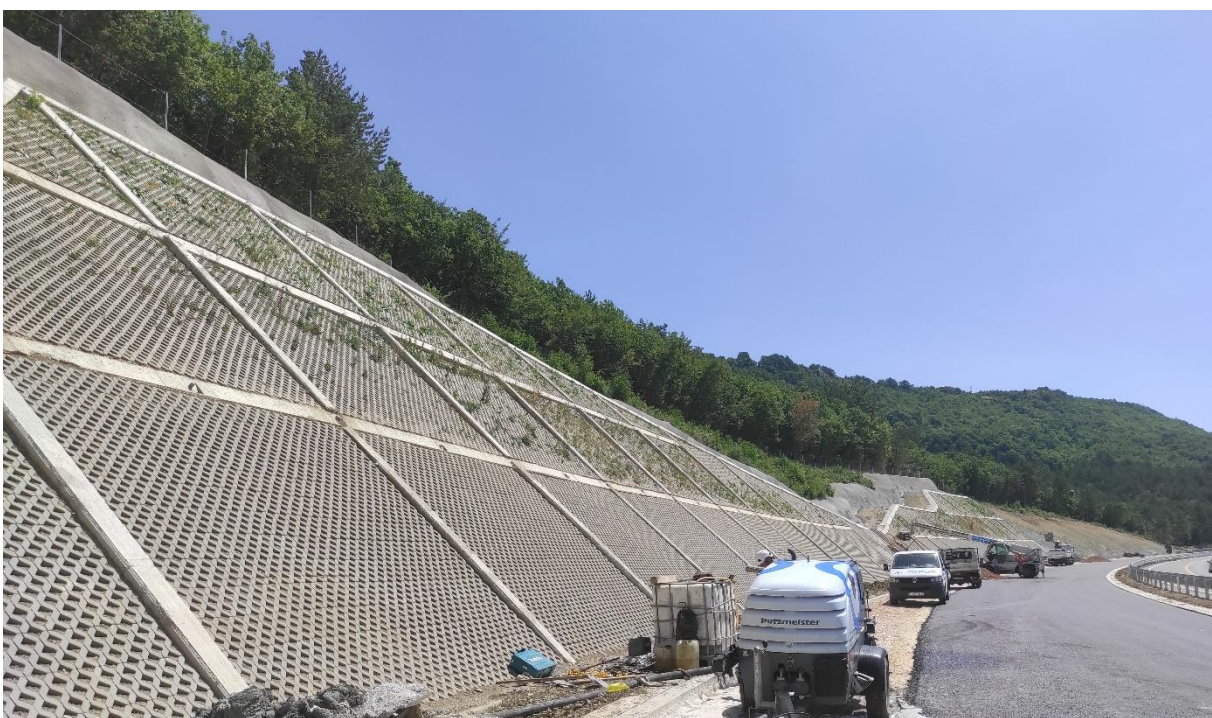
Slika 30. Zaštita pokosa roštiljnom konstrukcijom s Eko prstenovima
