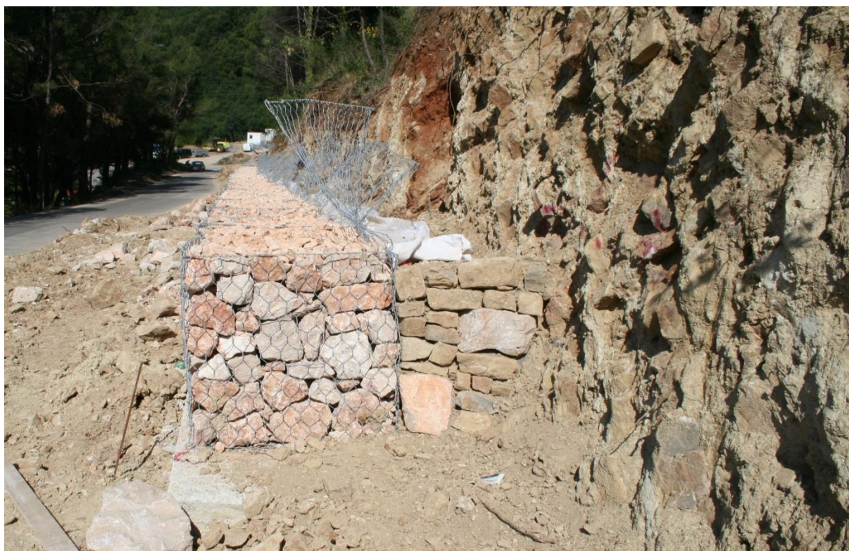
Slika 23. Punjenje gabionskih koševa kamenim materijalom
