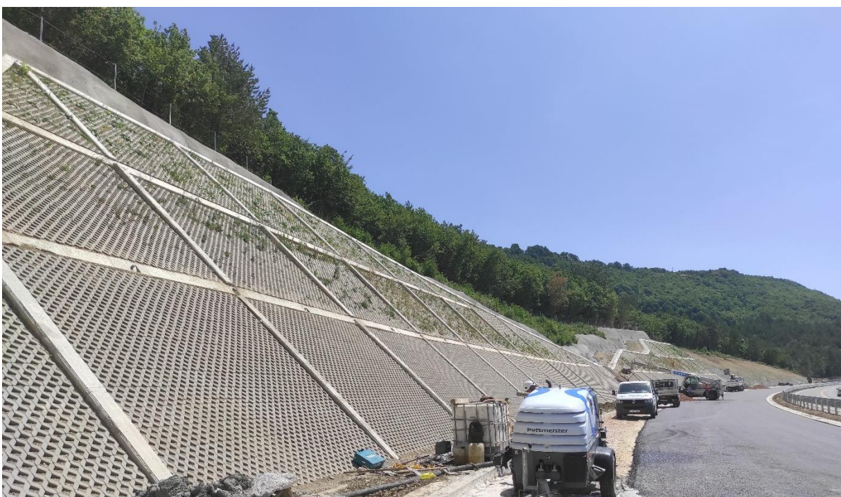
Slika 30. Zaštita pokosa roštiljnom konstrukcijom s Eko prstenovima
