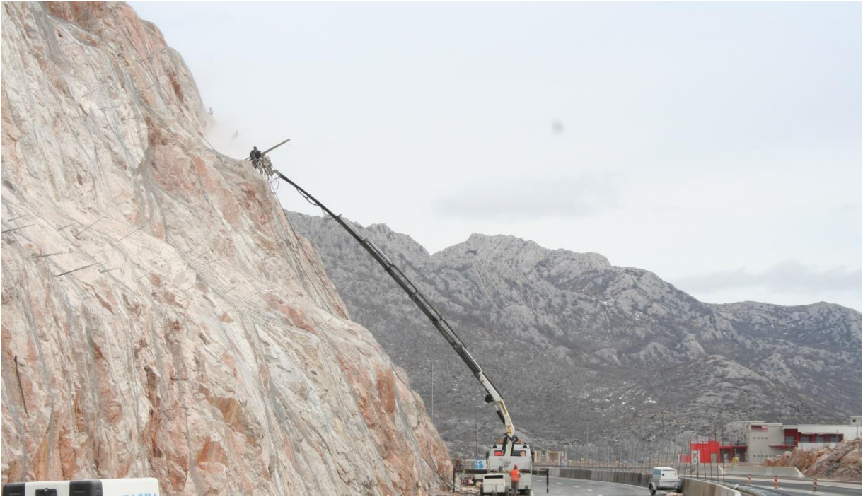
Slika 3. Bušenje sidara (izvor: Octopus Rijeka)
