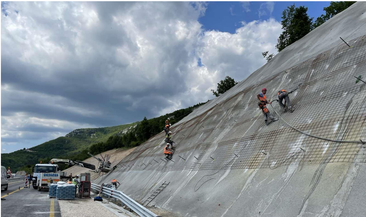
Slika 10. Izvedba zaštite pokosa mlaznim betonom, armaturnom mrežom i geotehničkim sidrima
