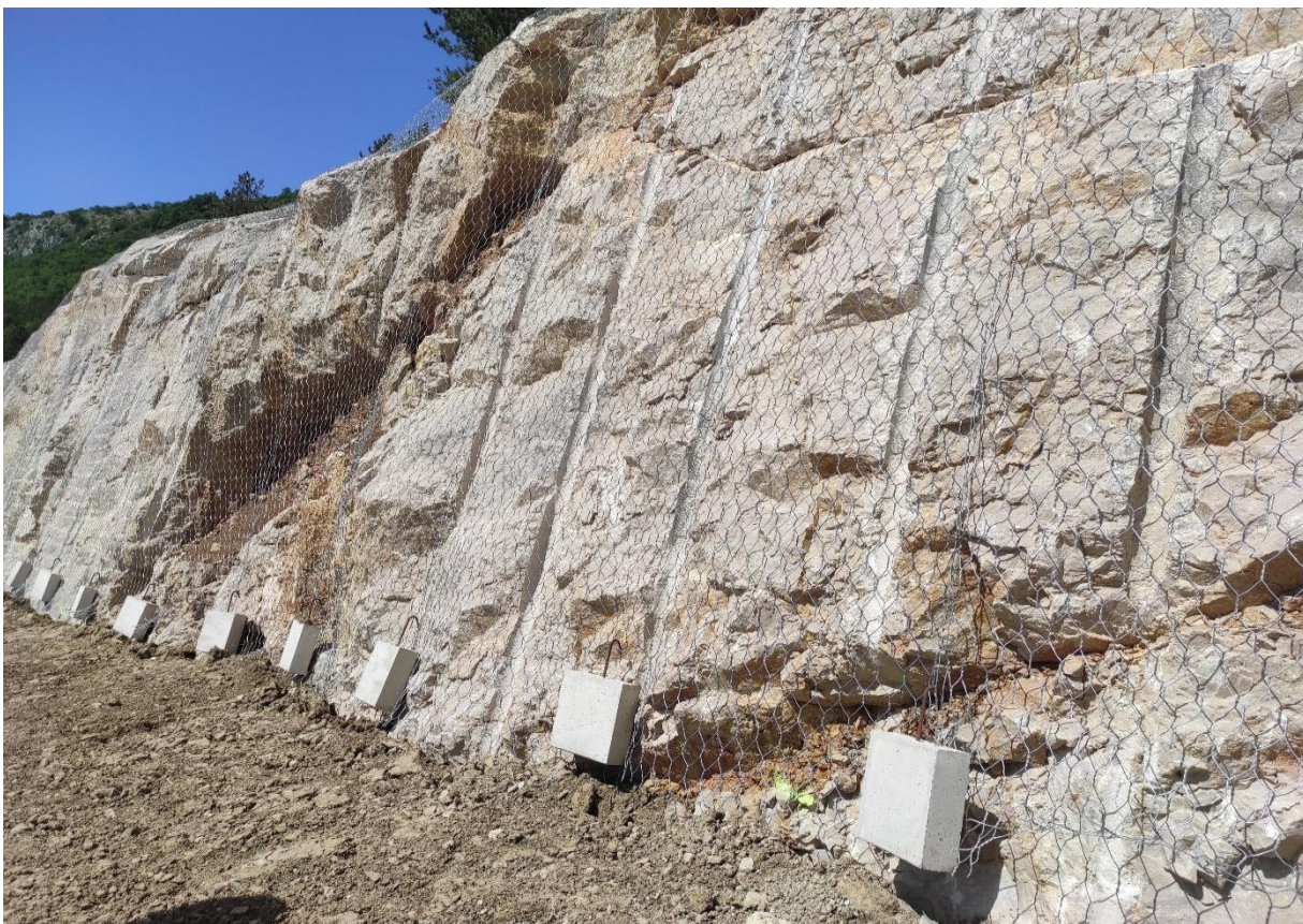
Slika 16. Zaštita pokosa heksagonalnom mrežom učvršćenom betonskim utezima
