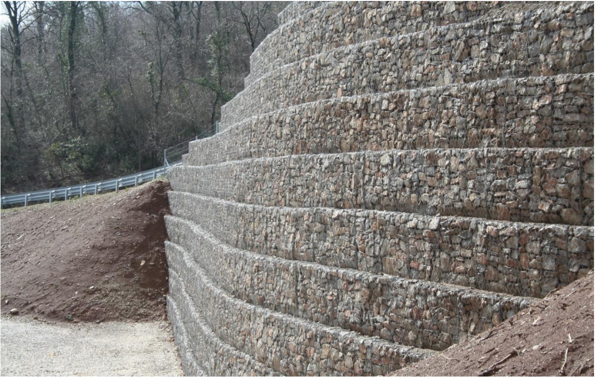
Slika 24. Zaštita pokosa Terramesh sustavom
