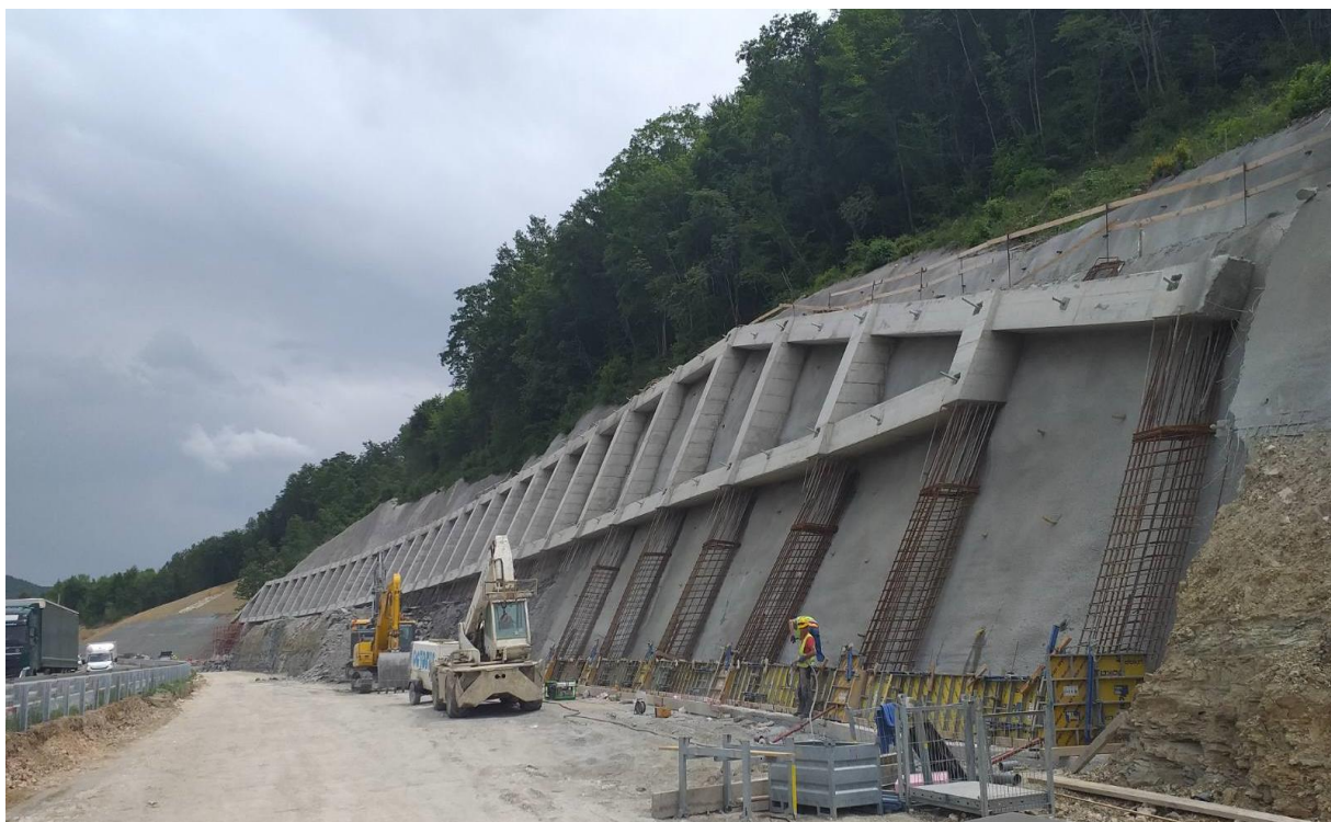
Slika 27. Roštiljna konstrukcija u fazi izvođenja, Istarski ipsilon
