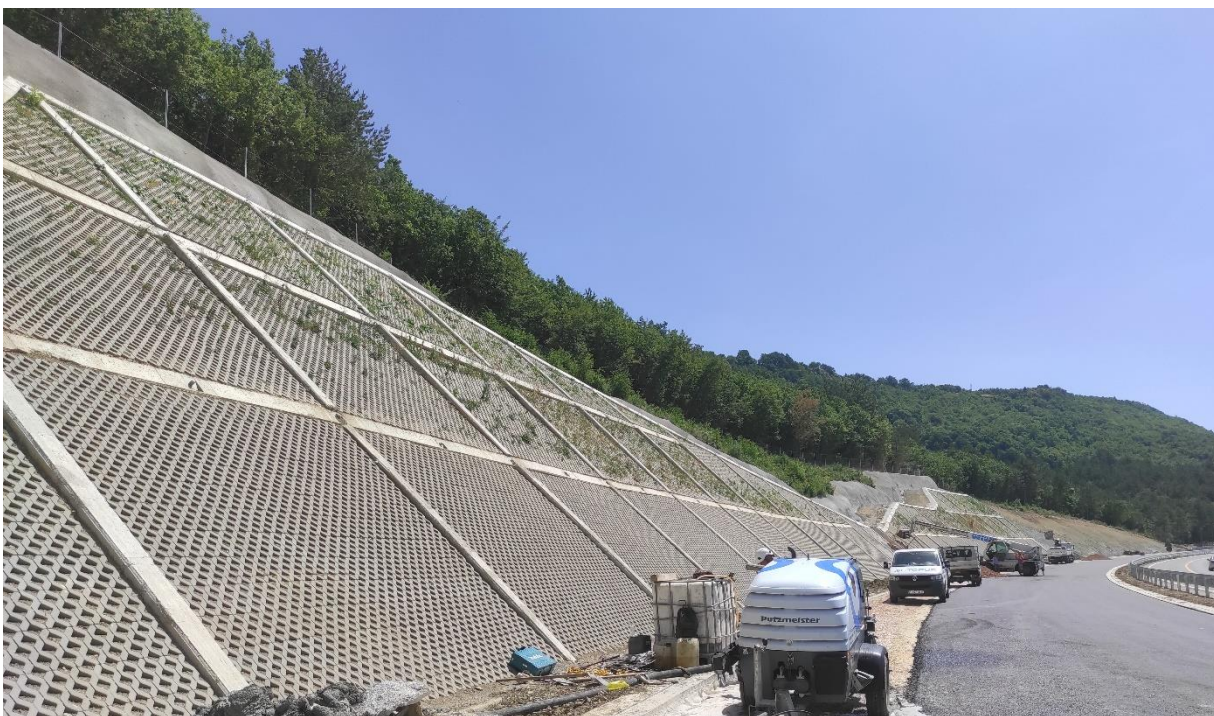
Slika 30. Zaštita pokosa roštiljnom konstrukcijom s Eko prstenovima
