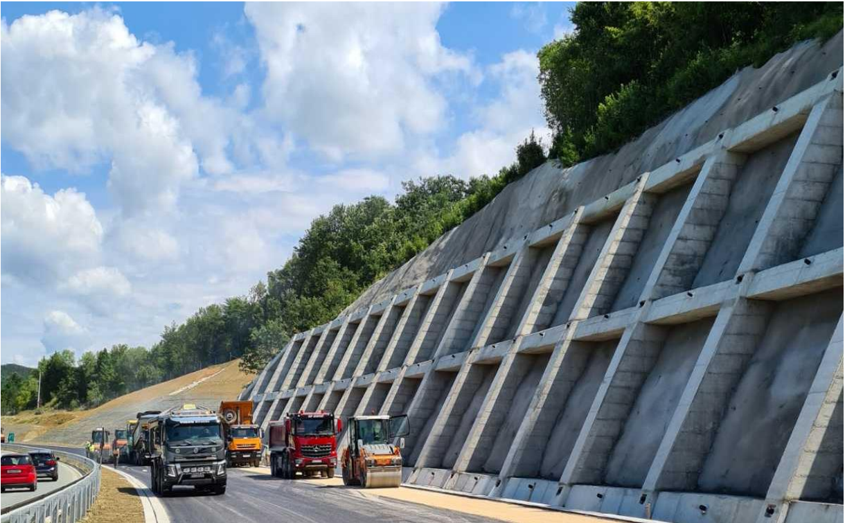
Slika 28. Roštiljna konstrukcija, Istarski ipsilon
