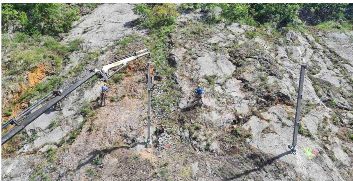
Slika 20. Postavljanje stupova barijere za zaštitu od odrona
