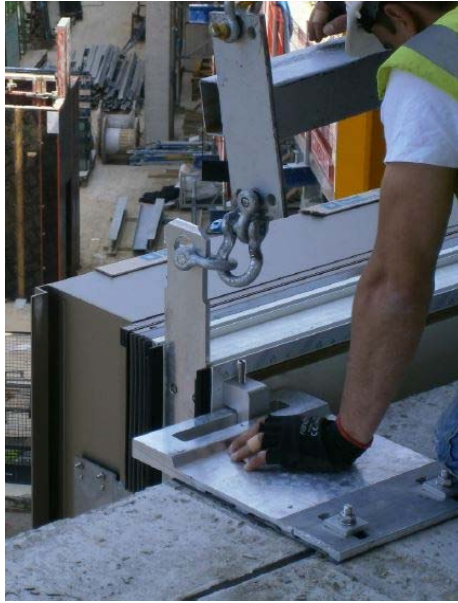
Grafička literatura 3: Nosač jediničnog sustava ovješениh fasada (Bracket unitised curtain wall system); (Grafička literatura autora)
