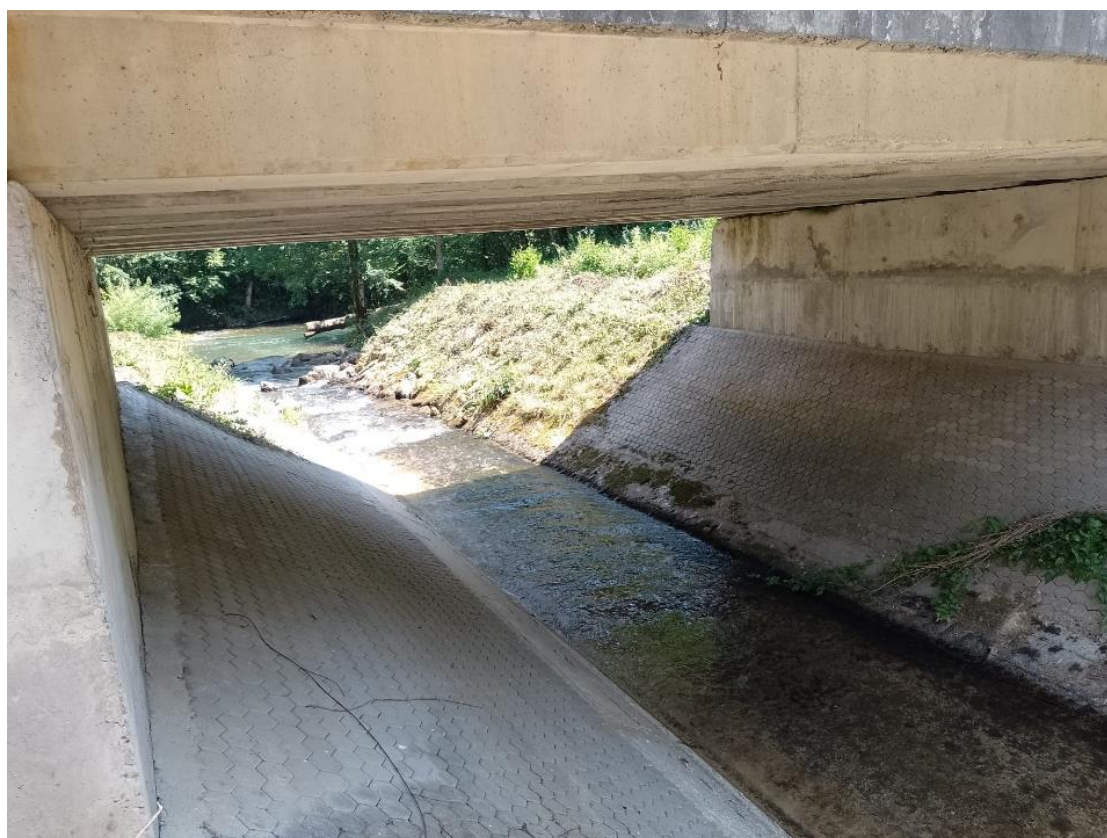
Slika 9 Propust mosta na prometnici Zamost - Hrvatsko
