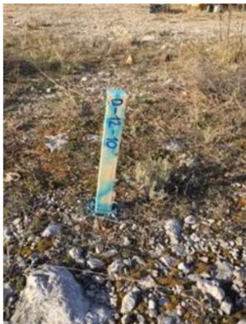
Slika 22: Geodetsko iskolčenje točaka na terenu [38]
